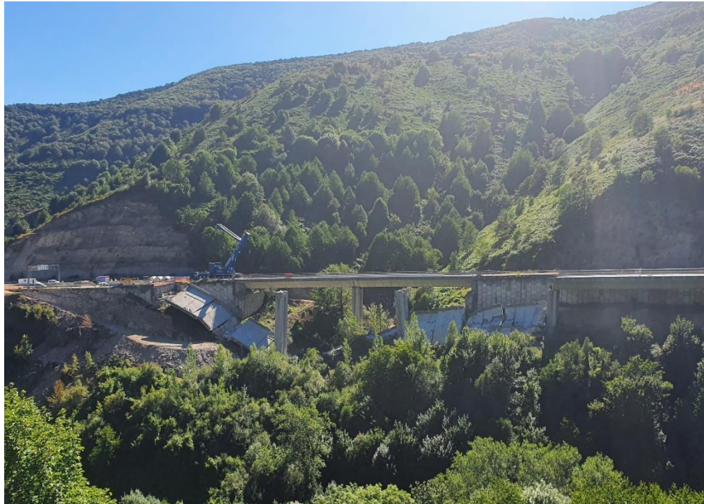
Imagen del estado actual de las pilas 1 y 2 del viaducto del Castro
