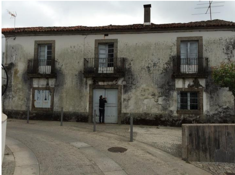
Foto 2. Edificio de Correos. Arzúa (A Coruña)
