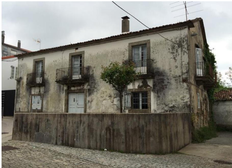
Foto 1. Edificio de Correos. Arzúa (A Coruña)
