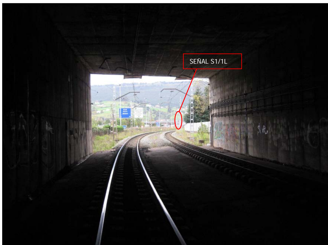
Visibilidad de la señal S1/1L desde el interior del falso túnel. A la izquierda vía 1 (general) y a la derecha vía 4 (que termina en el apeadero de La Cantábrica) Vista hacia lado Bilbao. (Fuente: Feve)
