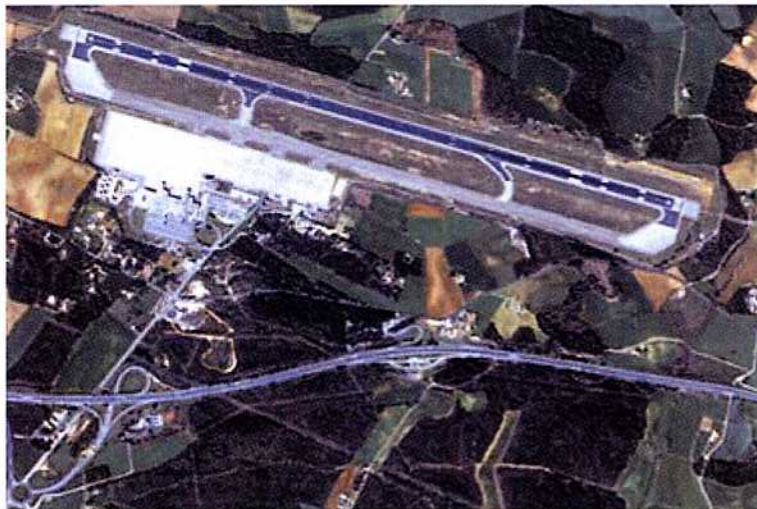
Ilustración 1.1.- Vista aérea del Aeropuerto de Girona
