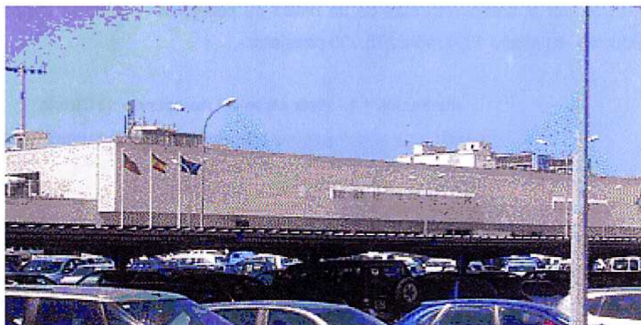
Ilustración 1.2.- Edificio Terminal de pasajeros
