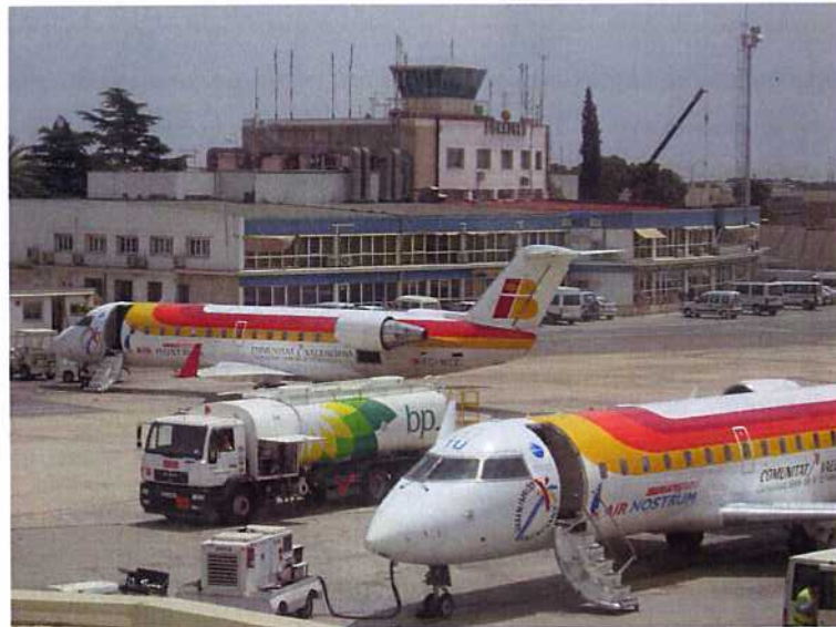
Ilustración 1.1.- Antiguo Edificio Terminal de Pasajeros
