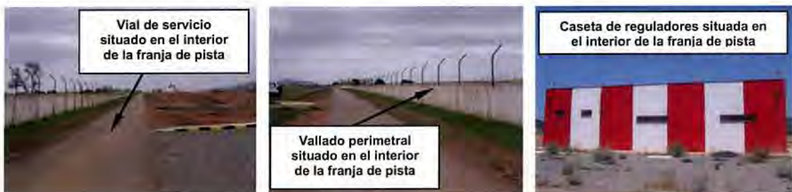
Ilustración 5.2.- Vial de servicio, vallado perimetral y caseta de reguladores
