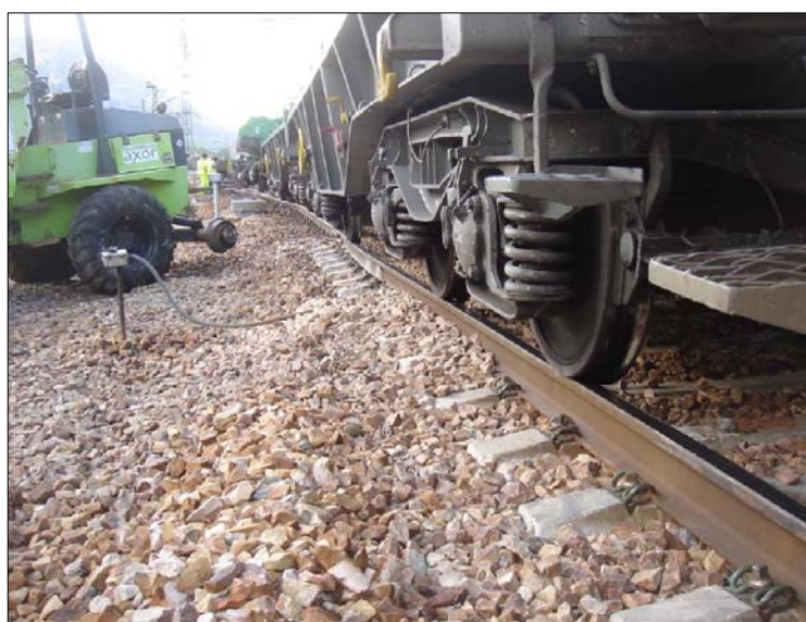
Desplazamiento de la vía en la zona de cambio de traviesas de hormigón a madera. Fuente: Renfe operadora.
