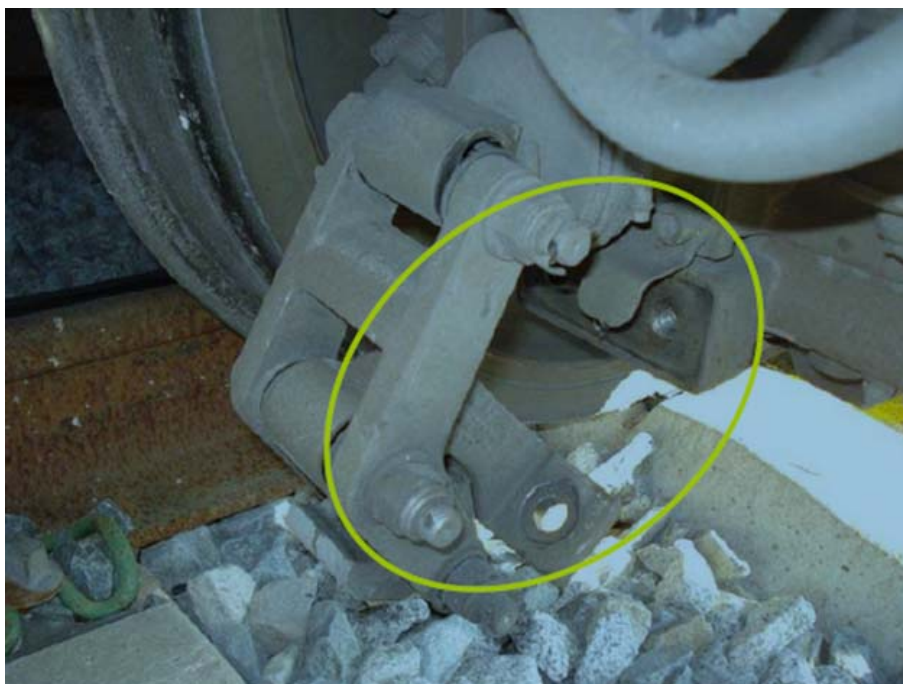
Vista de mecanismo de bloqueo de ancho de rueda descarrilada, con la chapa de seguridad deformada y sin los tornillos de sujeción. (Fuente: Renfe Operadora)
