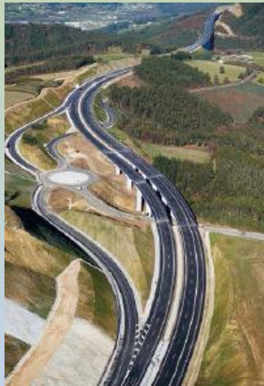
Viaducto de Curros – Enlace Lindin
