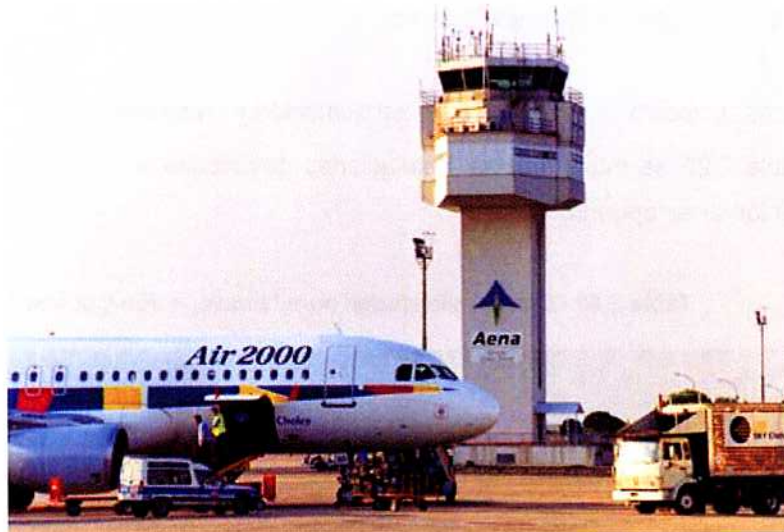
Ilustración 2.13.- Torre de Control
