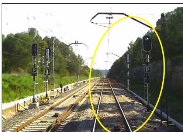
Señal intermedia 2268 y baliza ASFA de señal. (Fuente: Renfe Operadora)
