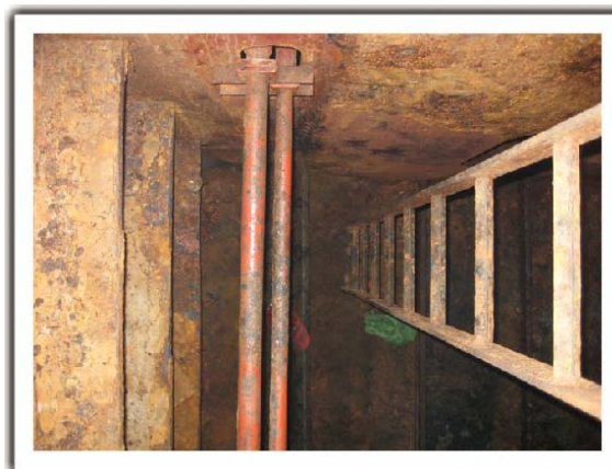
Figura 4. Interior del recinto donde quedaron inconscientes los tripulantes, visto desde la abertura.
