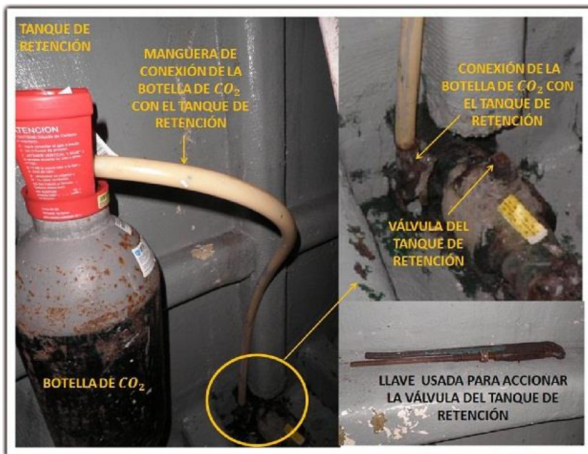
Figura 5. Conexión de la botella de CO 2 con el tanque de retención
