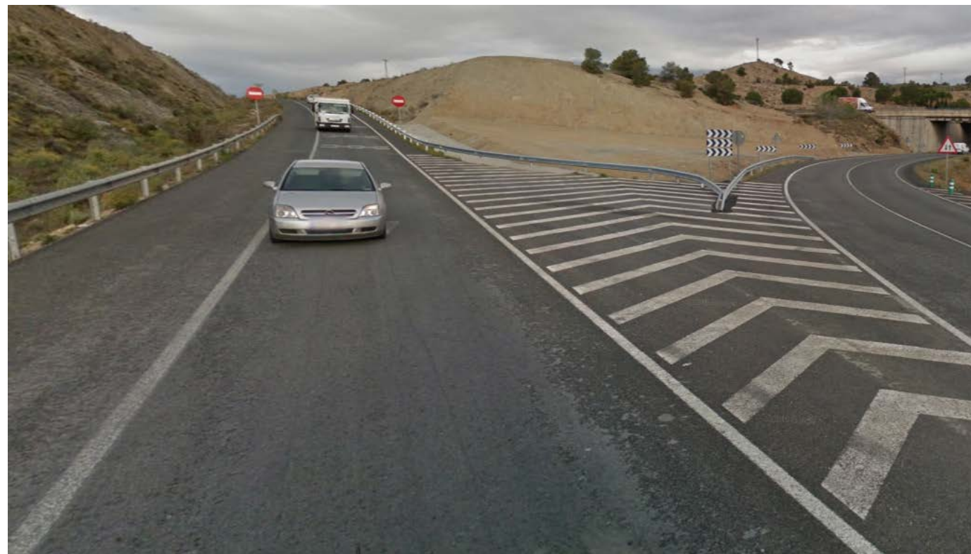
Foto 3: Ramal de salida 575 de la A7 sentido descendente
