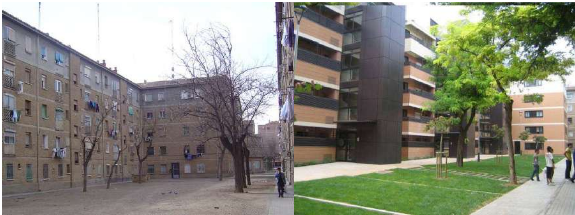
Figura 5.49. Ejemplos de mejora de la calidad arquitectónica y de la imagen de las fachadas en una rehabilitación que incluye la mejora energética de la envolvente.
