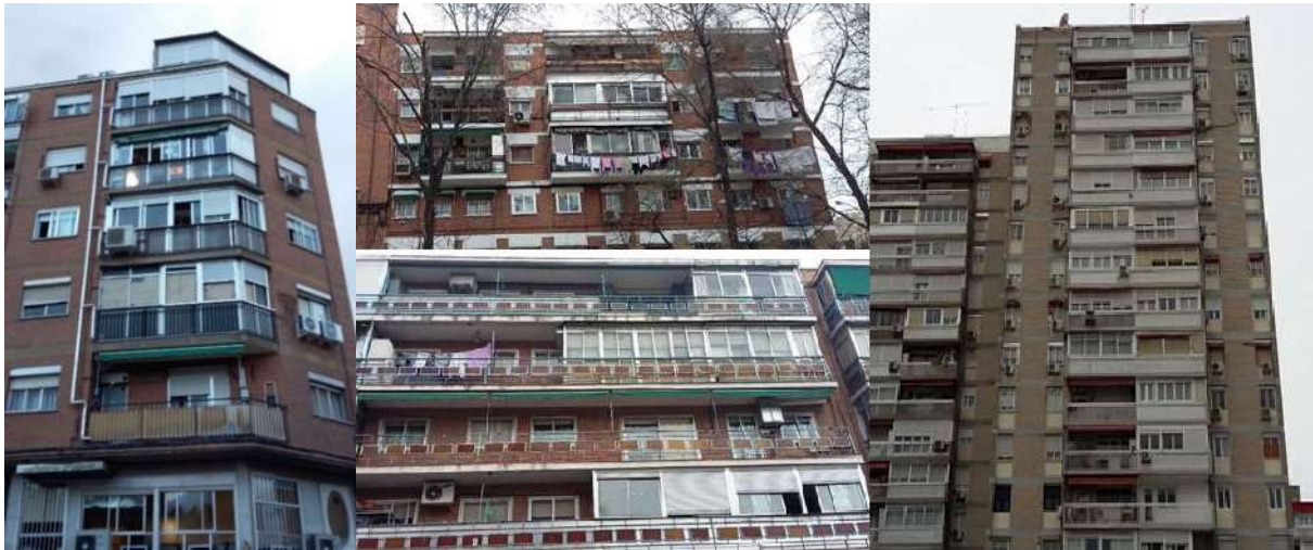
Figura 5.51. Ejemplos de cerramientos anárquicos e irregulares de terrazas. En el ejemplo de la derecha, el porcentaje de terrazas cerradas es tal que se ha convertido en la norma, configurando un cuerpo central de galerías acristaladas variopintas.
