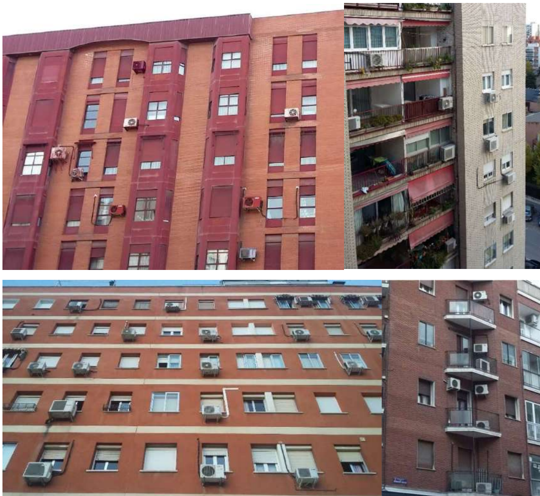
Figura 5.61. Ejemplos de mala integración de las bombas de calor en edificios residenciales de bloque de los años 60-80.
