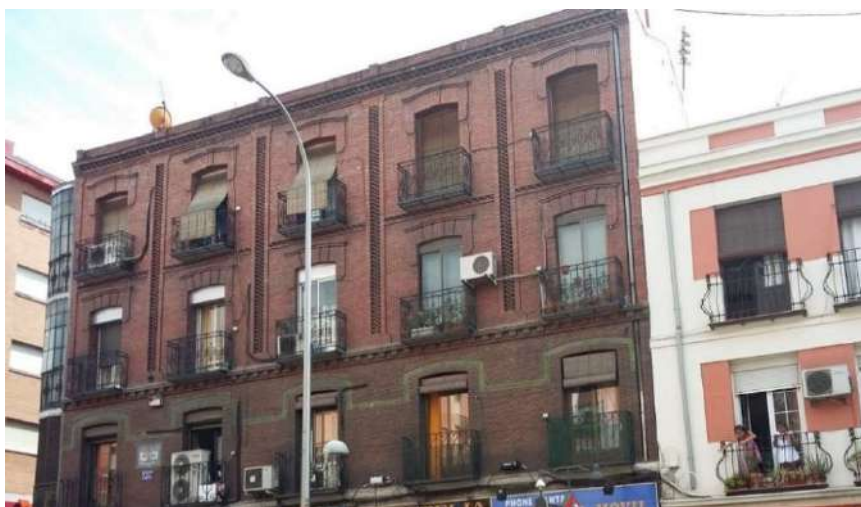
Figura 5.60. Arriba: Ejemplo de proliferación de bombas de calor en una fachada histórica. Abajo: Ejemplo de agrupación de bombas de calor en cubierta de un edificio histórico, eliminándolas de la fachada.
