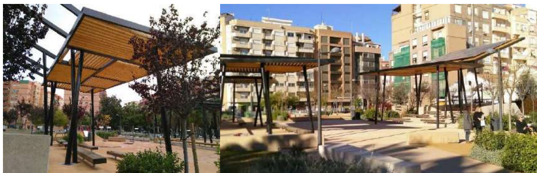
Figura 5.66. Pérgolas fotovoltaicas en el jardín de Morvedre, Valencia.
