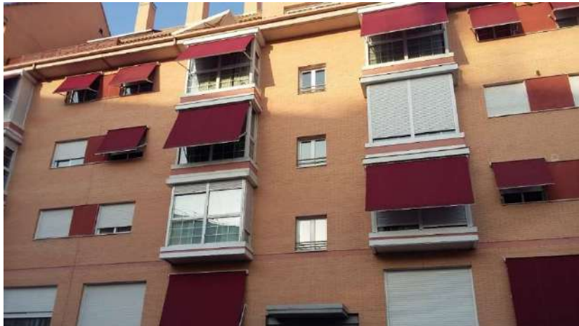
Figura 5.62. Ejemplo de correcta integración arquitectónica de los dispositivos bioclimáticos (toldos).
