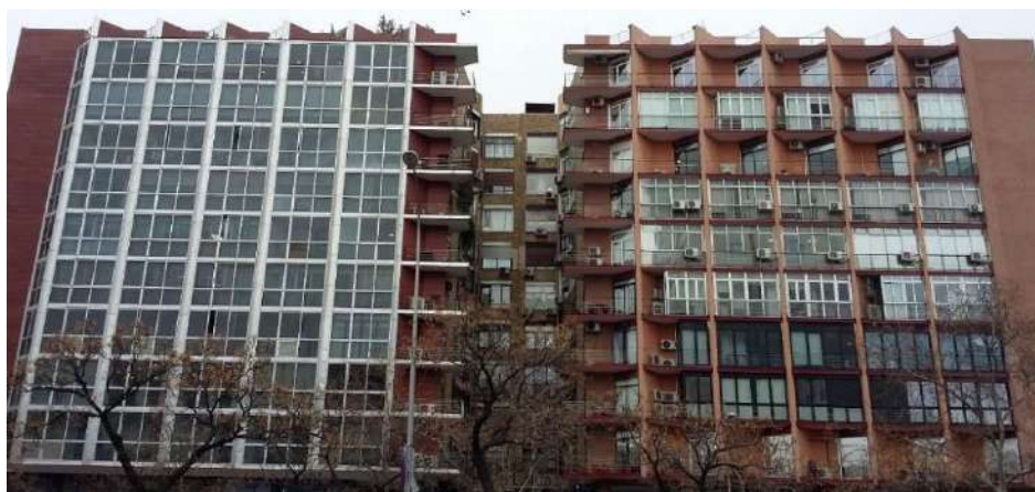
Figura 5.52. Vista de dos edificios con terrazas, originalmente simétricos. El de la derecha muestra el resultado del cerramiento anárquico de las terrazas y la proliferación de bombas de calor, y el de la izquierda una intervención unitaria de rehabilitación de la fachada.
