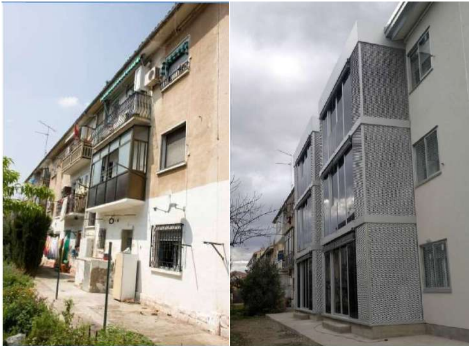
Figura 5.56. Ampliación de la vivienda a través del espacio de la terraza en el proyecto Lourdes Renove Tudela. (Antes y después).
