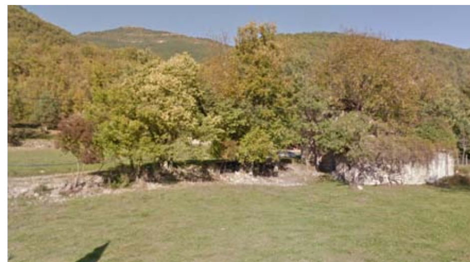
Camino de acceso y construcción en P.K. 8+220 M.D.
