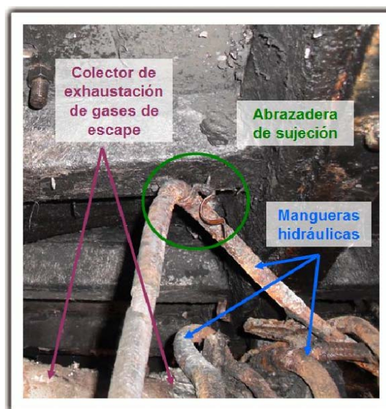
Figura 6. Detalle del anclaje de las mangueras hidráulicas al techo de la cámara de máquinas
