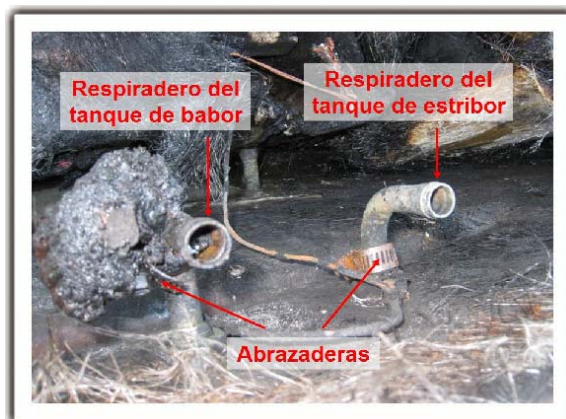
Figura 6. Vista de los respiraderos por la parte interior del casco
