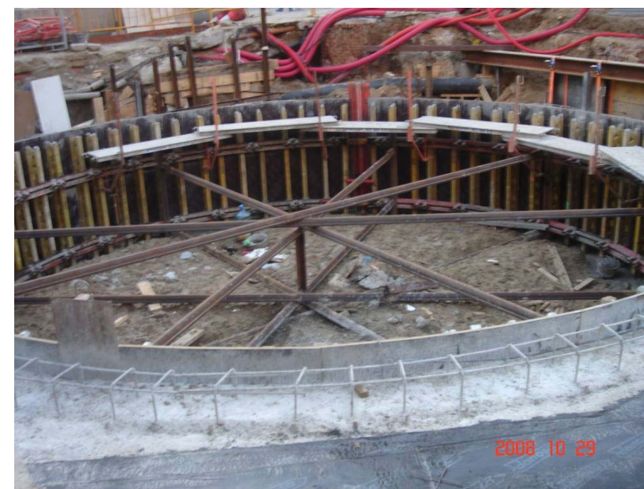
Encofrado colocado en el primer anillo.
