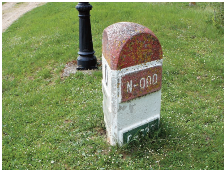
►BU-627 PK 27 Sandoval de la Reina, Burgos. Esta joya mojonera es rarísima. Se trata de un mojón del Plan Peña para dos calzadas en su PK 0. En este caso de la N-620 (Burgos-Salamanca) y de la comarcal C-627 (Villanueva de Argaño-Herrera de Pisuerga).
