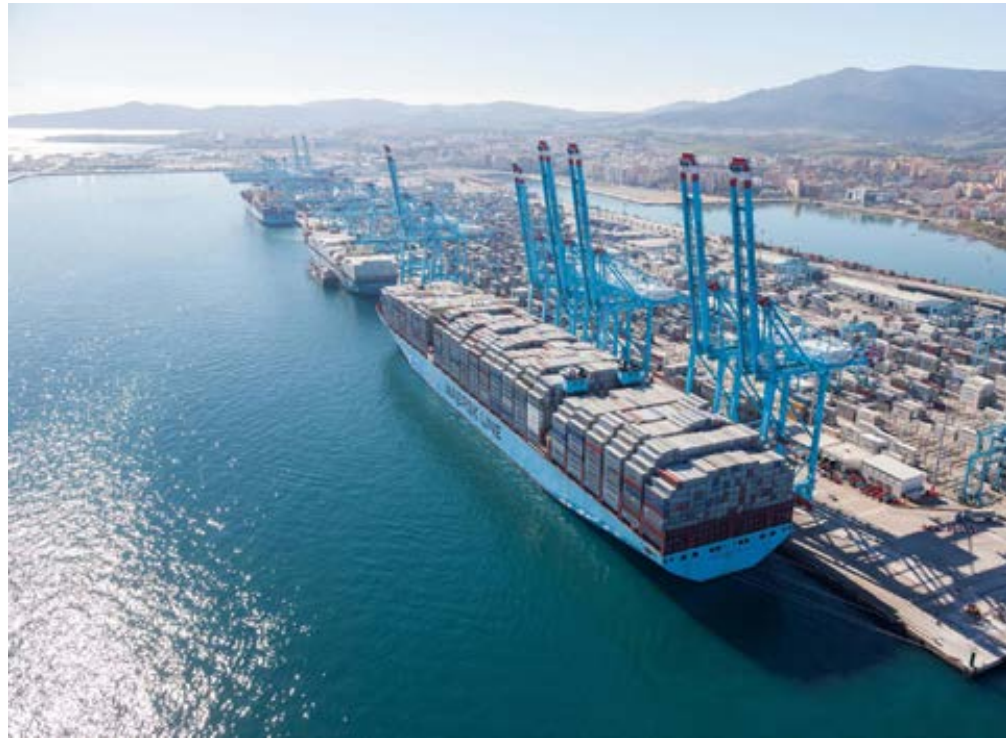
Terminal de Isla Verde en el puerto Bahía de Algeciras.
