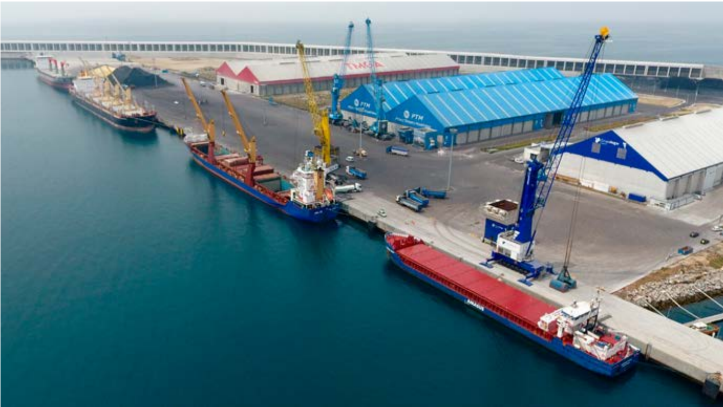
Muelle para productos graneleros en el puerto exterior de A Coruña.
