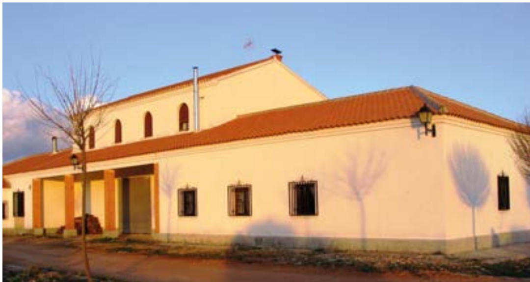
Estación de la Vía Verde de la Sierra de Alcaraz, provincia de Albacete.
