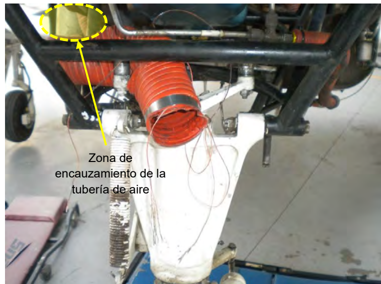
Figura 6. Fotografía de la tubería de aire colocada en la posición en la que se encontró después de retirar la aeronave de la pista
