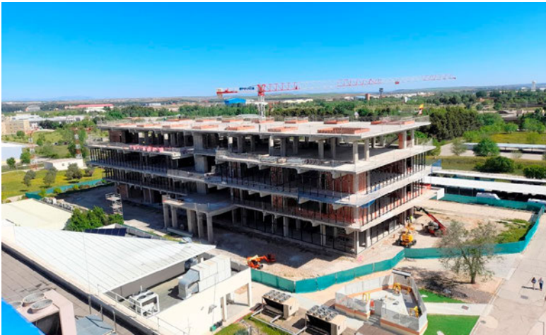
Estado actual de la obra el 5 de mayo de 2022. Vista desde esquina suroeste.
