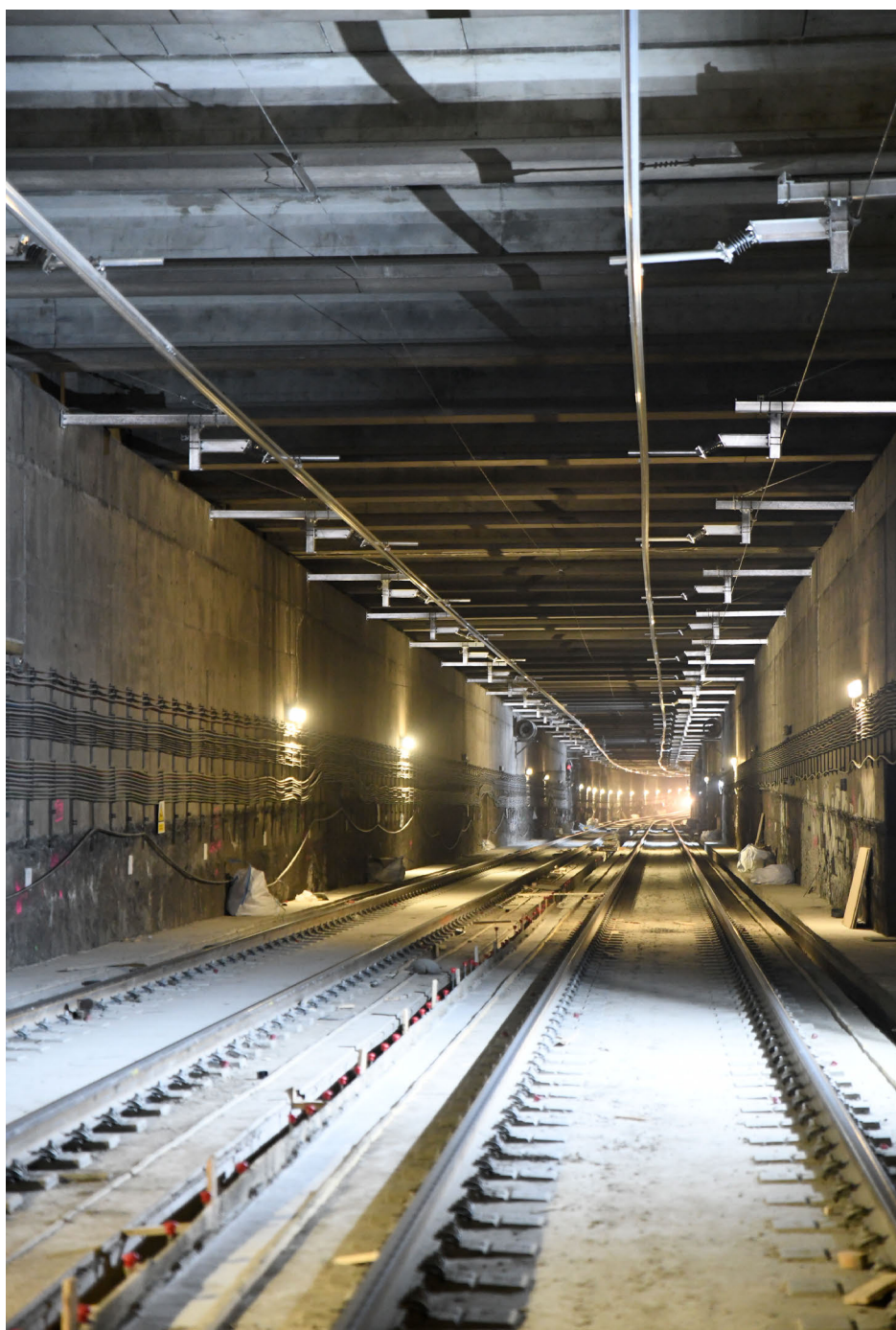
Túnel de Getafe.
