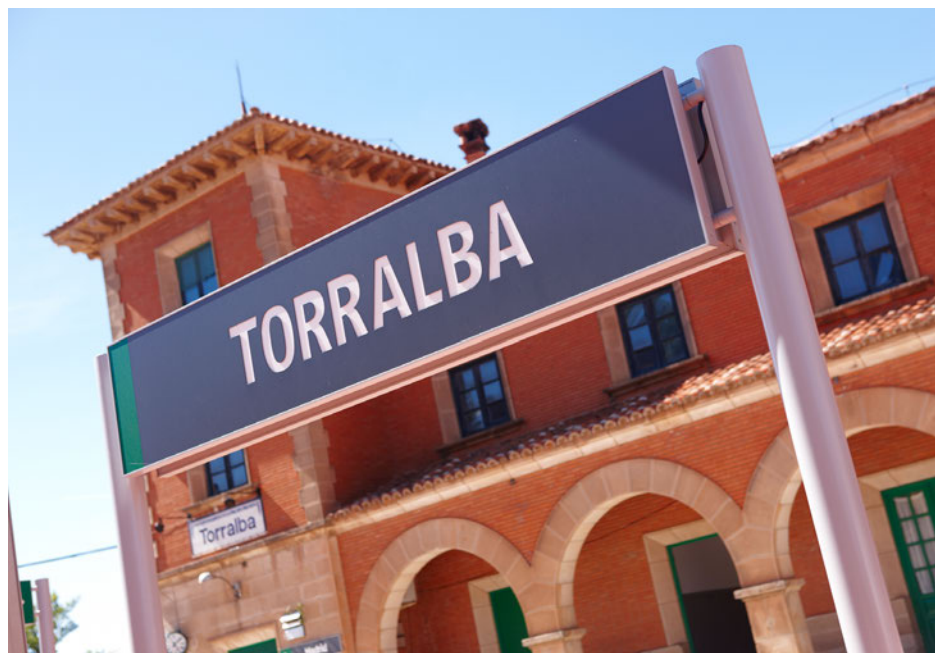
A la izquierda estación de Soria y encima de estas líneas estación de Torralba.
