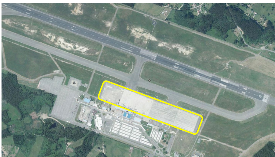
Ilustración 2.4.- Plataforma de estacionamiento de aeronaves
