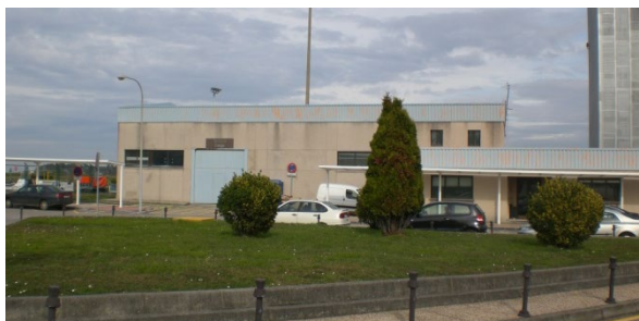
Ilustración 2.26.- Terminal de Carga vista desde lado tierra
