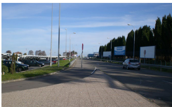
Ilustración 2.22.- Vial de salida del aparcamiento cerrado que sirve de bolsa de taxis
