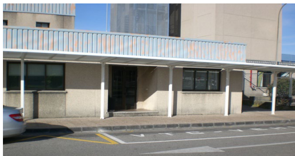
Ilustración 2.23.- Plazas para vehículos de transporte con conductor
