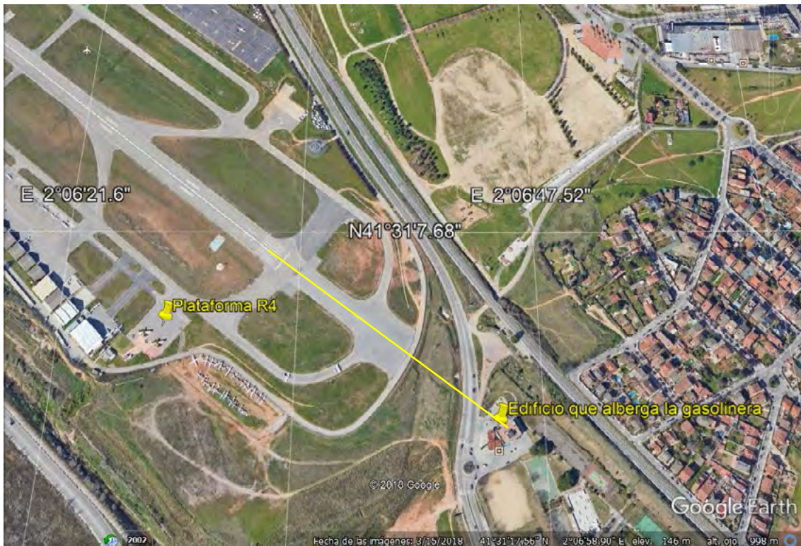
Ilustración 8: Detalle de la pista 31 del aeropuerto de Sabadell y del edificio que alberga la gasolinera
