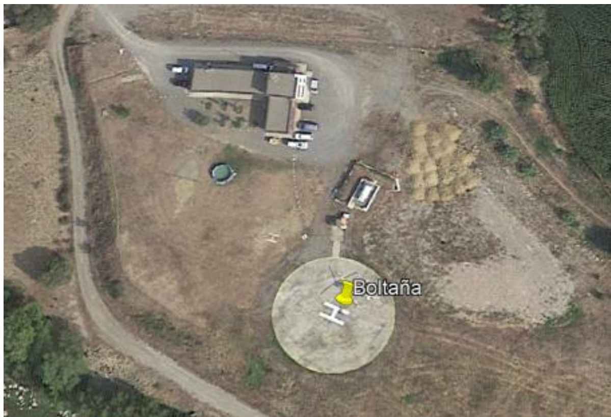
Ilustración 1: Vista aérea de la base de Boltaña
