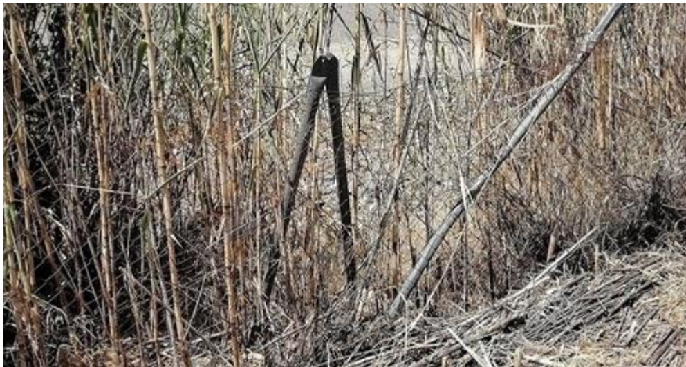
Figura 1. Daños en valla metálica
