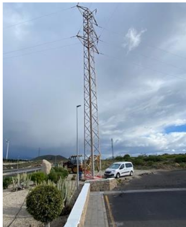
FIG. 4 VISTA DE APOYO A405009 TRAS LA REPARACIÓN
