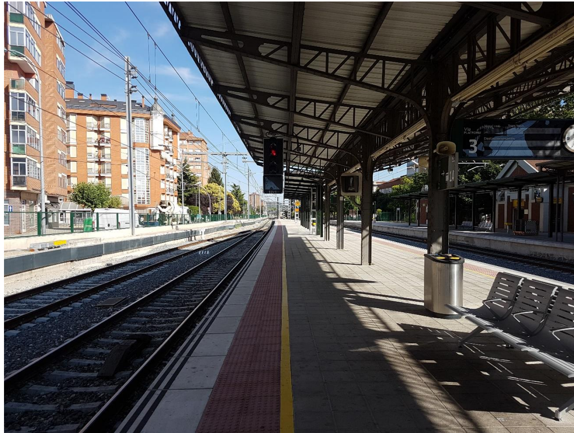
Vista de las vías de la estación de Palencia en sentido Valladolid
