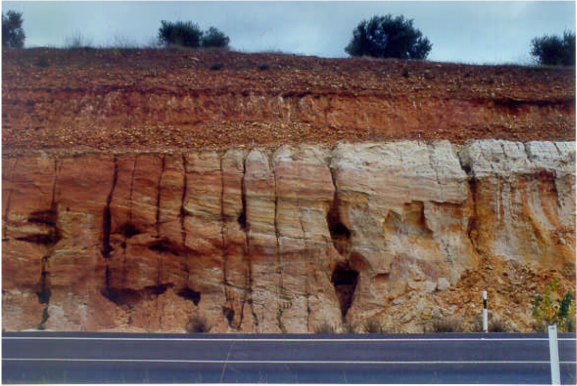
Foto 46. Facies arenosas y caolínicas del grupo litológico (321b). Nótese el acarreamiento y los pequeños desplomes generados en la esquina derecha con motivo de las fuertes precipitaciones del invierno 1996-97. El talud culmina con un nivel de terraza. Puente de Luciana.
