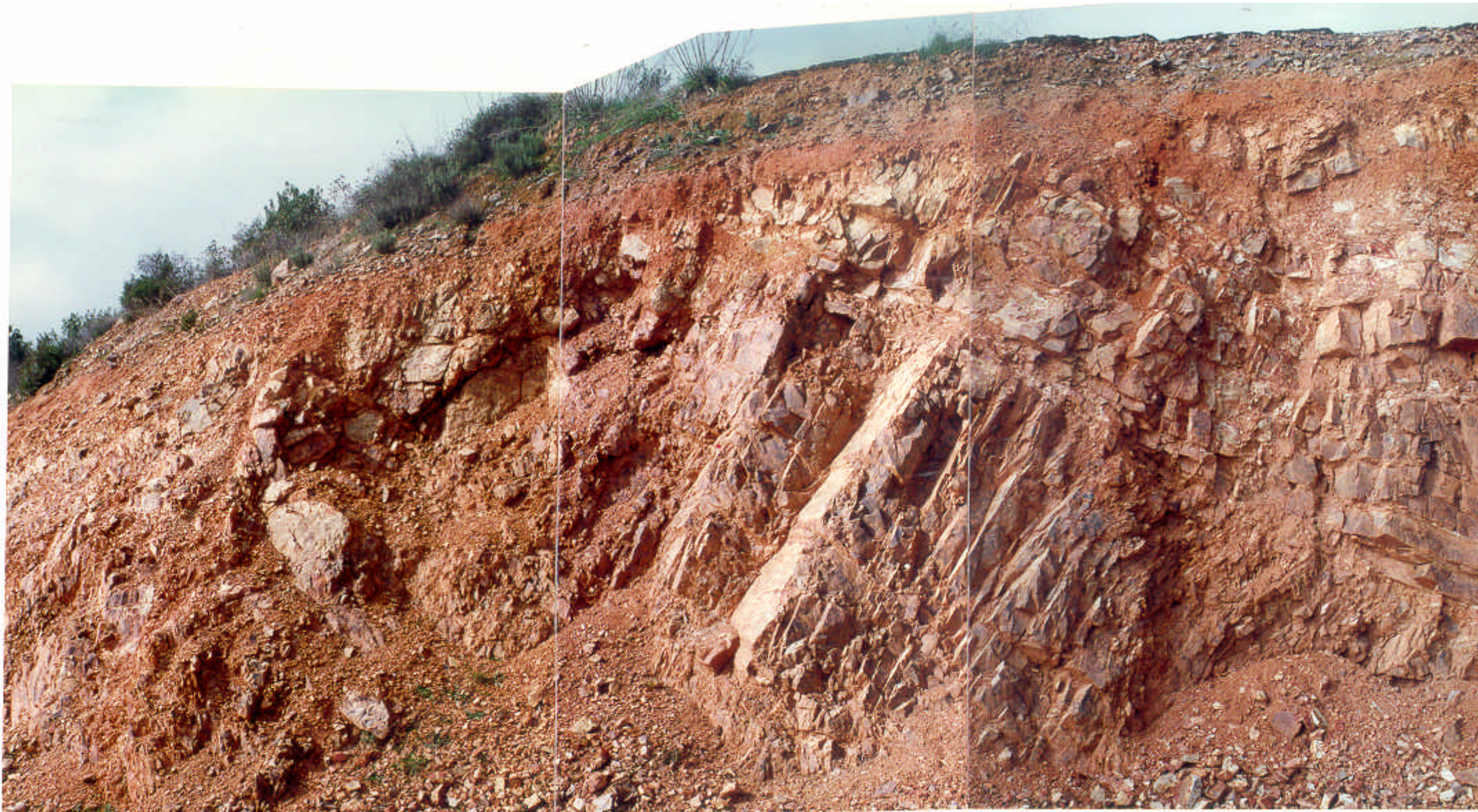
Foto 29. Cuarcitas del grupo litológico (121a). En el talud se observan problemas de desprendimientos y corrimientos de cuñas. En la esquina superior izquierda de la foto, donde se observa una rotura fósil del talud. En la mitad derecha se puede apreciar una estructura de movimiento a favor esencialmente de una superficie de estratificación con rotura de los paquetes superiores y flexión de los inferiores.
