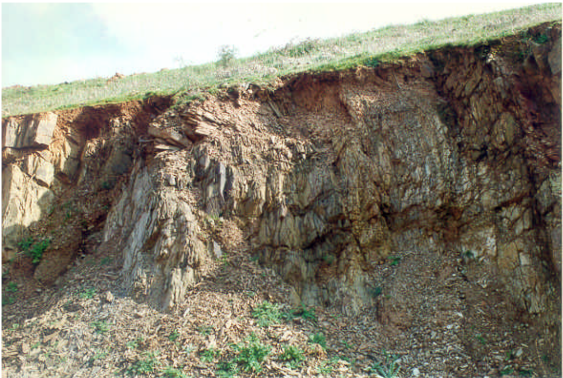
Foto 23. Vuelco de estratos y cicatrices de corrimiento de cuñas en los taludes del grupo litológico (112c). Confluencia del arroyo de Porzuna y de la Media Legua.
