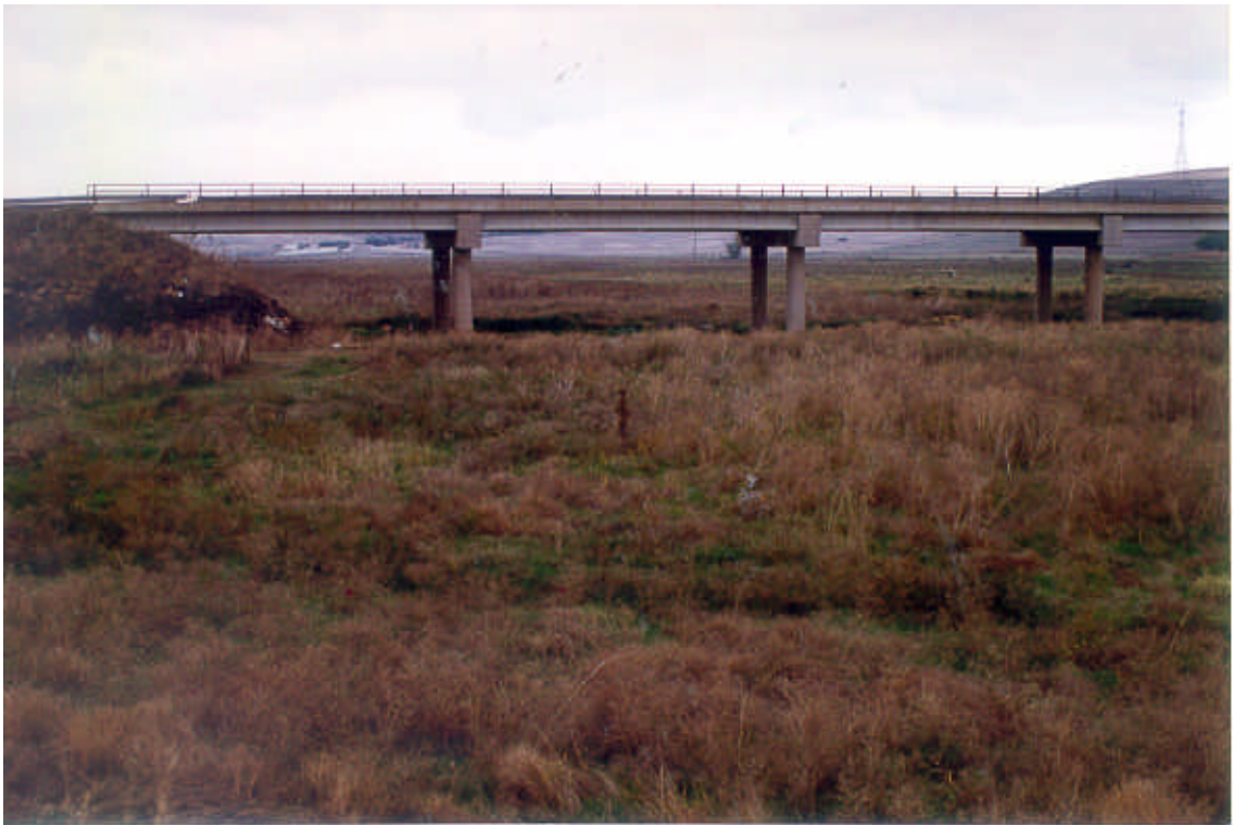
Foto 34. Lecho aluvial y llanura de inundación pantanosa del río Guadiana. Puente de Alarcos. Límite oriental del Tramo.
