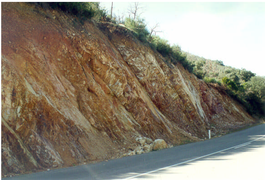
Foto 27. Problema de corrimiento de cuñas en los taludes de excavación del grupo litológico (121b). Pk(15) de la carretera regional 721. Se trata de un tramo de transición al grupo litológico 121c. Los planos estratigráficos que actúan como superficies de corrimiento contienen un horizonte pizarroso centimétrico o decimétrico alterado y brechificado como consecuencia de haber actuado como superficies de despegue en el plegamiento hercínico.
