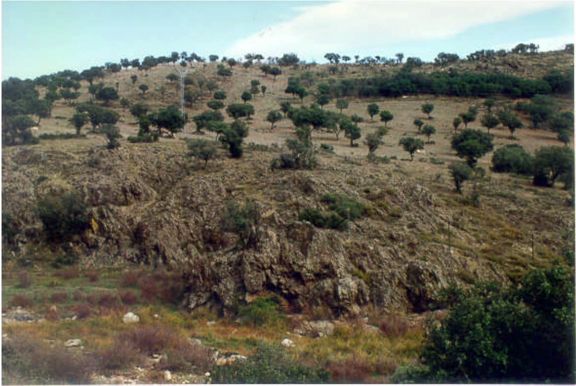
Foto 56. Relieve y aspecto superficial de las rocas constitutivas del grupo litológico (010b). En primer término se observan brechas intraformacionales. En un plano intermedio se observa la serie detrítico carbonatada coronada por las dolomías del grupo 010d. Casa de Navalsordo. Proximidades del castillo de Hojalora.
