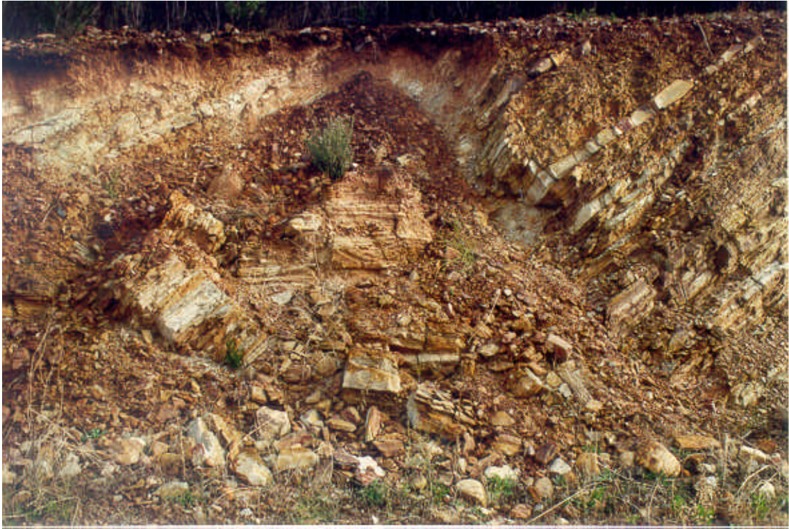
Foto 25. Corrimiento en pizarras del grupo 122a en la zona de transición al grupo 121c. Carretera nacional 430 pk.(260).
