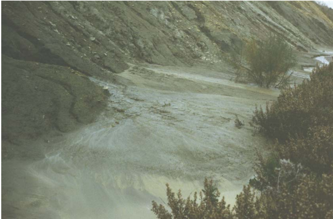
Figura 3.44. Proceso de erosión en un talud del grupo (230), en donde puede verse la acumulación al pie del mismo, en forma de abanico, del material erosionado. Proximidades del p.k. 19,5 (variante en construcción abandonada) (Hoja 1062-2).
