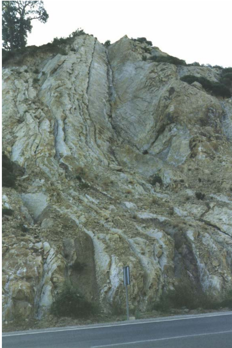
Figura 3.77. Ejemplo de cicatriz de cuña formada en un talud próximo al p.k. 84 de la carretera C-440 (Hoja 1074-1), realizado en las areniscas del grupo (321a).
