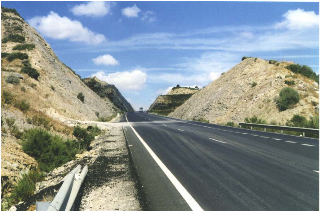
Figura 3.53. Taludes de altura media, realizados en las proximidades del p.k. 45 de la carretera C-440 (Hoja 1070-4), que afectan a los yesos del grupo (213a). Puede observarse la ausencia total de inestabilidades rotacionales.
