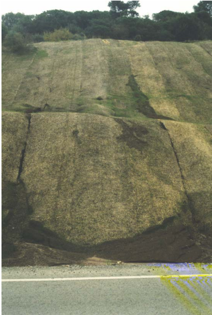
Figura 3.72. Visión local del mismo talud de la Figura anterior, en el que pueden verse con más detalle las deformaciones de la superficie del talud, y observar cómo el efecto de la erosión continúa por debajo del geotextil.
