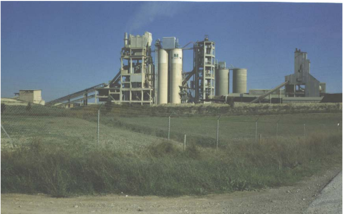
Figura 3.22. Fábrica de Cemento ALBA, situada en el p.k. 9 de la carretera C-440 (Hoja 1062-4).
