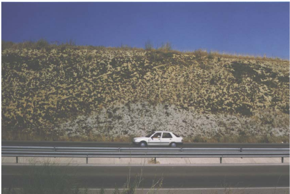
Figura 3.29. Aspecto de los materiales del grupo (321g), en un talud, totalmente estable, de la carretera N-IV, próximo al p.k. 647 (Hoja 1062-4). Pueden observarse los tres tipos de litologías descritas, así como la estructura de las mismas, por medio de los lechos de arenisca.
