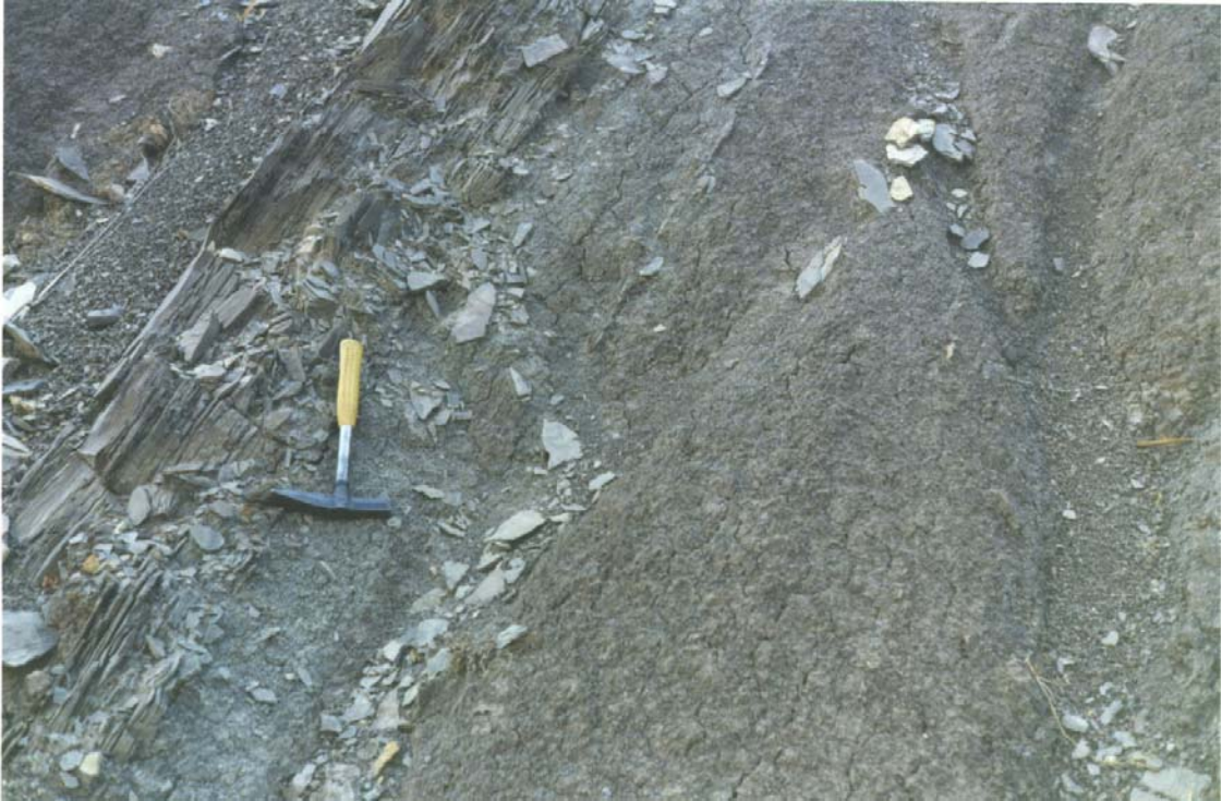
Figura 3.66. Aspecto de detalle de las arcillas rojas y grises, así como de una intercalación limolítica, del grupo (321b), en las proximidades del p.k. 84 de la carretera C-440 (Hoja 1074-1). Obsérvese el aspecto lajoso de las limolitas.
