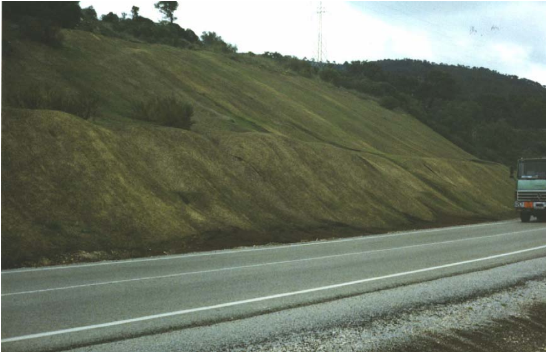
Figura 3.71. Talud de altura media realizado en las arcillas del grupo (321b), en las proximidades del p.k. 80 de la carretera C-440 (Hoja 1074-1). Se ha construido una berma intermedia, que modifica su inclinación, y se ha cubierto con geotextil, para evitar la erosión. Obsérvense también las deformaciones en la superficie del talud.
