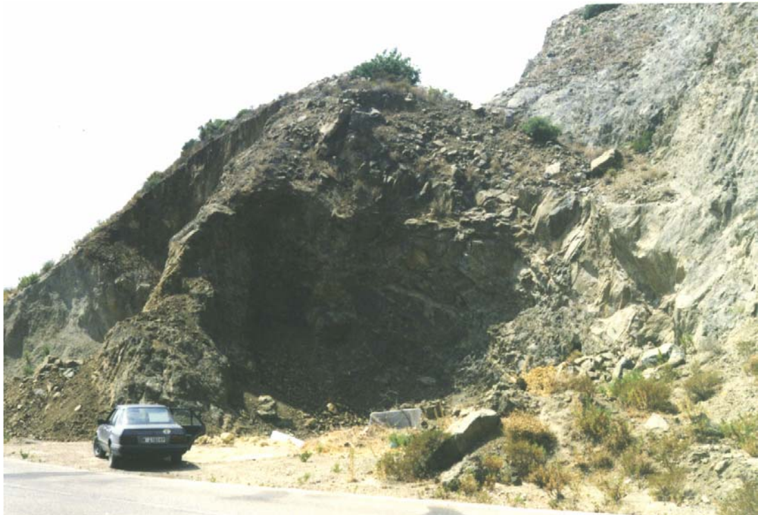
Figura 5.3. Cantera abierta en las ofitas del grupo (213c) y actualmente sin actividad (YR-24). Proximidades de la localidad de Alcalá de los Gazules (Hoja 1070-4).
