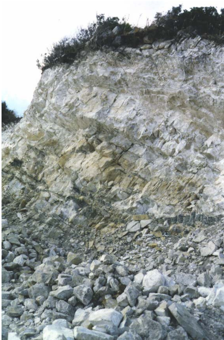
Figura 3.68 Aspecto de detalle de un bloque de caliza con Microcodium, inserto en la formación (321b), que ha sido parcialmente explotado en cantera. Proximidades de la cantera Las Pilas (Hoja 1069-1).
