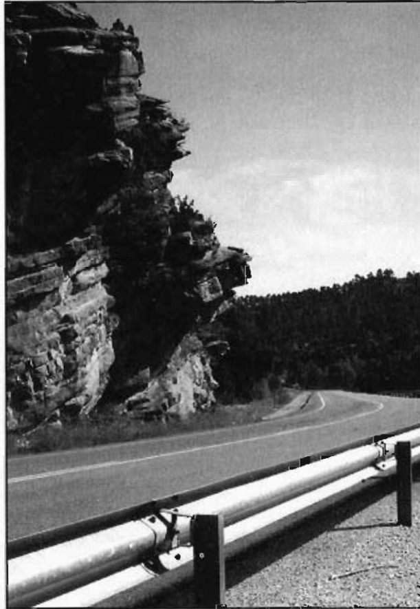
Figura 3.69.- Talud de altura media realizado en las areniscas de la formación (211d), en el p.k. 137,2 de la carretera N-420 (Hoja 636-4). Puede apreciarse el buzamiento de los estratos y la cornisa potencialmente inestable, situada en la parte baja del talud.
