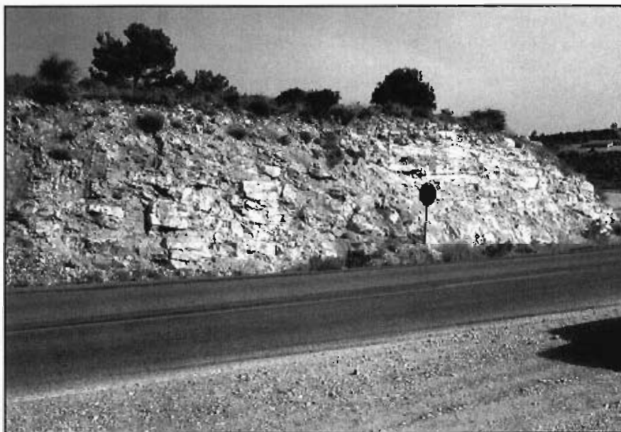
Figura 3.32.- Talud realizado en el p. k. 129 de la carretera N-420 (Hoja 636-3). Puede observarse cómo la fracturación afecta a estas rocas, disgregándolas en bloques.
