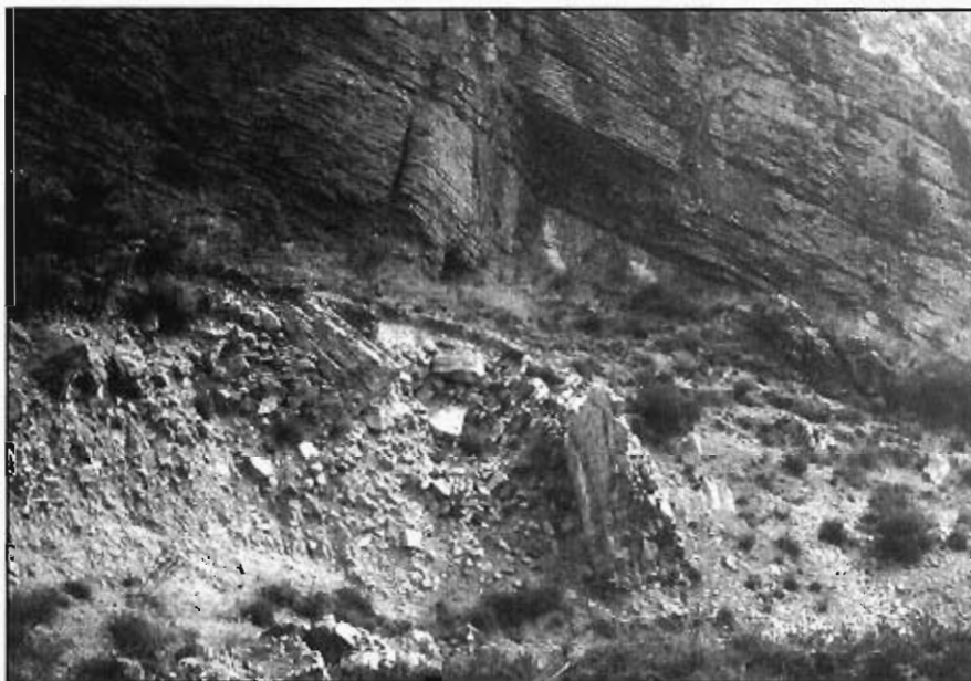
Figura 3.45.- Coluvión desarrollado al pie de uno de los macizos calcáreos del tramo. Puede observarse el tamaño de los cantos y de los bloques que componen la fracción grosera de las formación.
