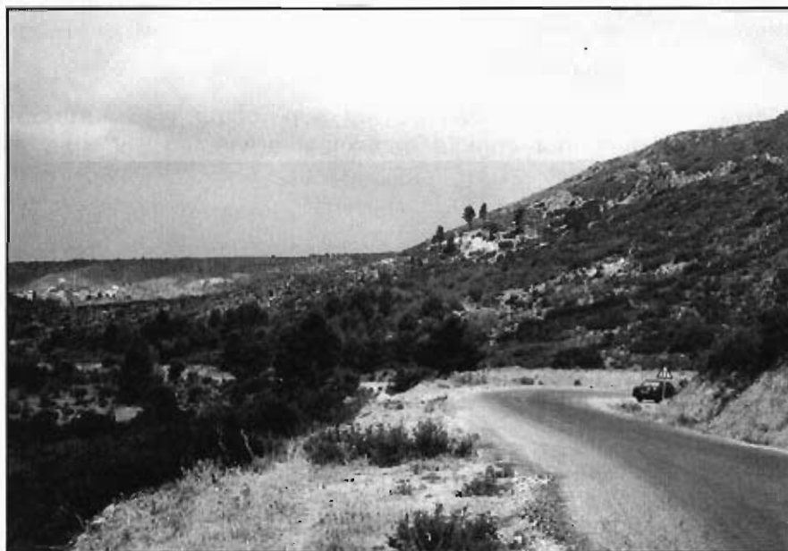
Figura 3.63.- Ladera formada en los materiales arcillosos y yesíferos del Keuper (grupo 213), en las que pueden observarse las huellas de la inestabilidad que producen estos materiales. Vista de la carretera local de Villora a Mira, tomada desde el p.k. 29 (Hoja 664-1).
