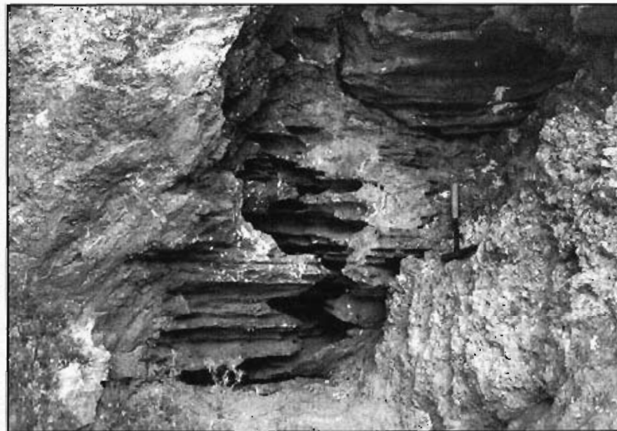
Figura 3.62.- Conducto kárstico producido en un nivel de yesos del grupo (213), en las proximidades del p.k. 137 de la carretera N-420 (Hoja 636-4).
