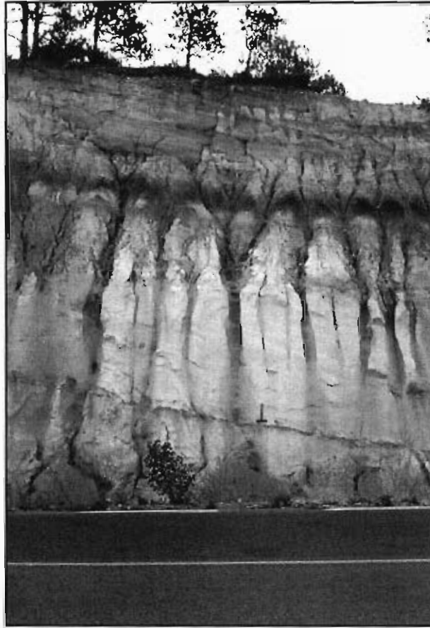
Figura 3.37.- Acarcavamientos producidos en un talud realizado en los materiales arenosos del grupo 231c, en las proximidades de la localidad de Carboneras de Guadazaón (Hoja 636-3). Puede observarse también la disposición estructural de los materiales.
