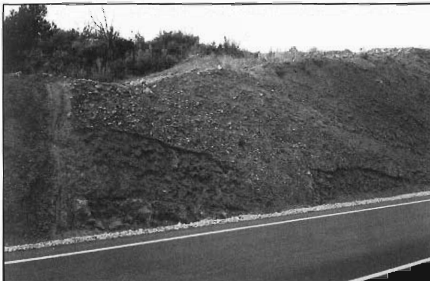
Figura 3.22.- Ejemplo de disposición de los materiales arcillosos y conglomeráticos del grupo (321a), que pueden ser observados en un talud de la carretera de Cardenete a Vállora (Hoja 664-1).
