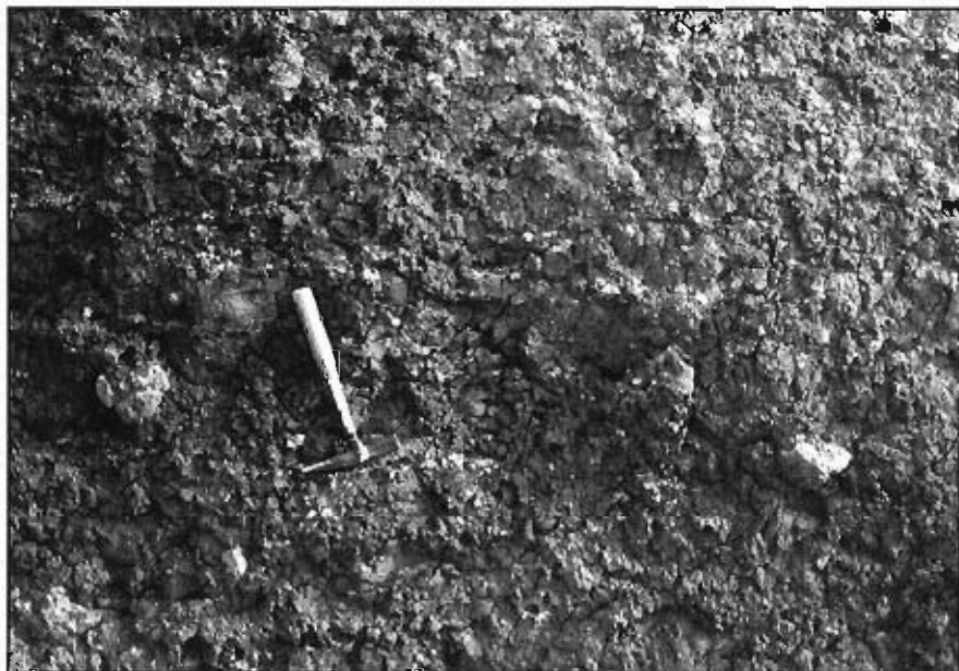
Figura 3.21.- Detalle de las arcillas del grupo (321a), en las proximidades de la localidad de Villora (Hoja 664-2). Puede observarse la fisuración producida por la desecación y retracción de las arcillas.
