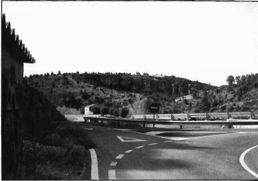
Figura 3.59.- Banco calco-dolomítico de la formación (220), que muestra una disposición estructural regular, al carecer la ladera de inestabilidades.
