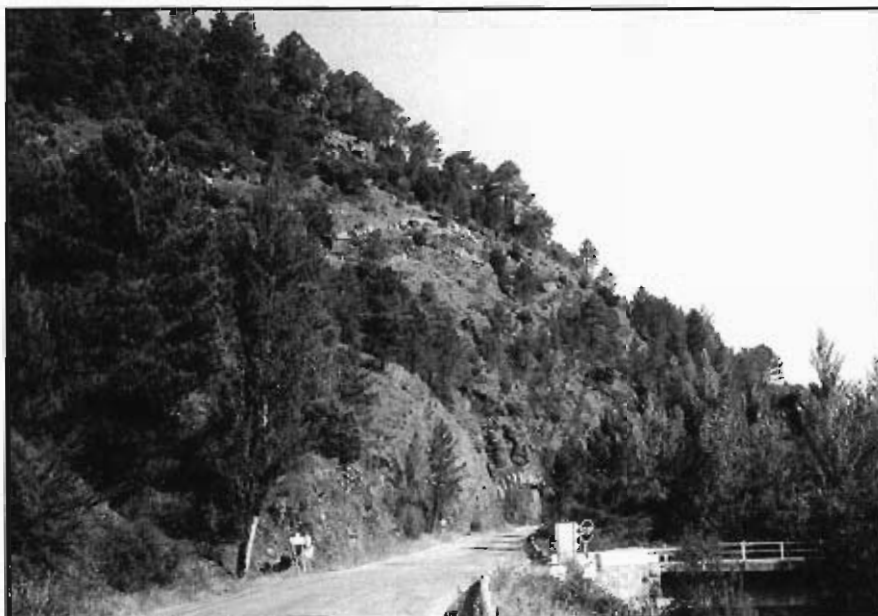
Figura 3.84.- Talud de altura media realizado en los materiales del grupo 132, en el p.k. 144,5 de la antigua carretera N-420, a la altura del cruce de la carretera local a Boniches (Hoja 636-1).
