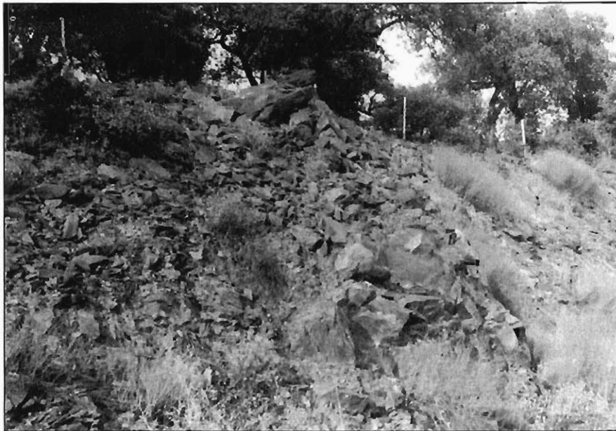
Fig. 3.12.- Aspecto de las pizarras y areniscas del grupo 120, en uno de los taludes realizados en las proximidades del Cortijo Ventas del Ciervo. (918-4).
