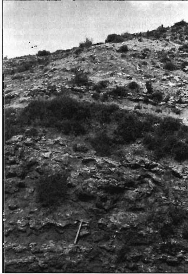
Fig. 3.14.— Aspecto del grupo 321a en el Alto de Majuelos. Obsérvese el buzamiento que presentan las capas en su parte superior. (Hoja 234-1).
