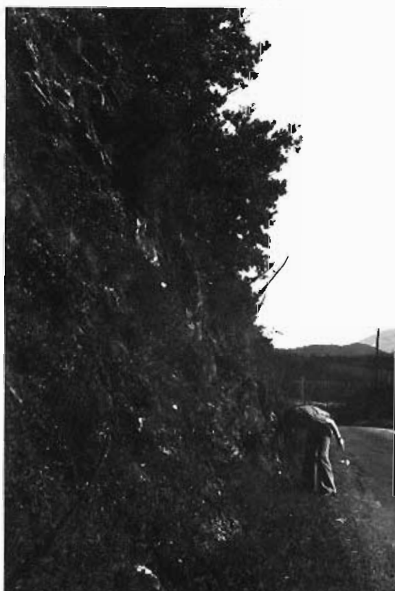
Foto 14.— Talud excavado en el grupo 231g
