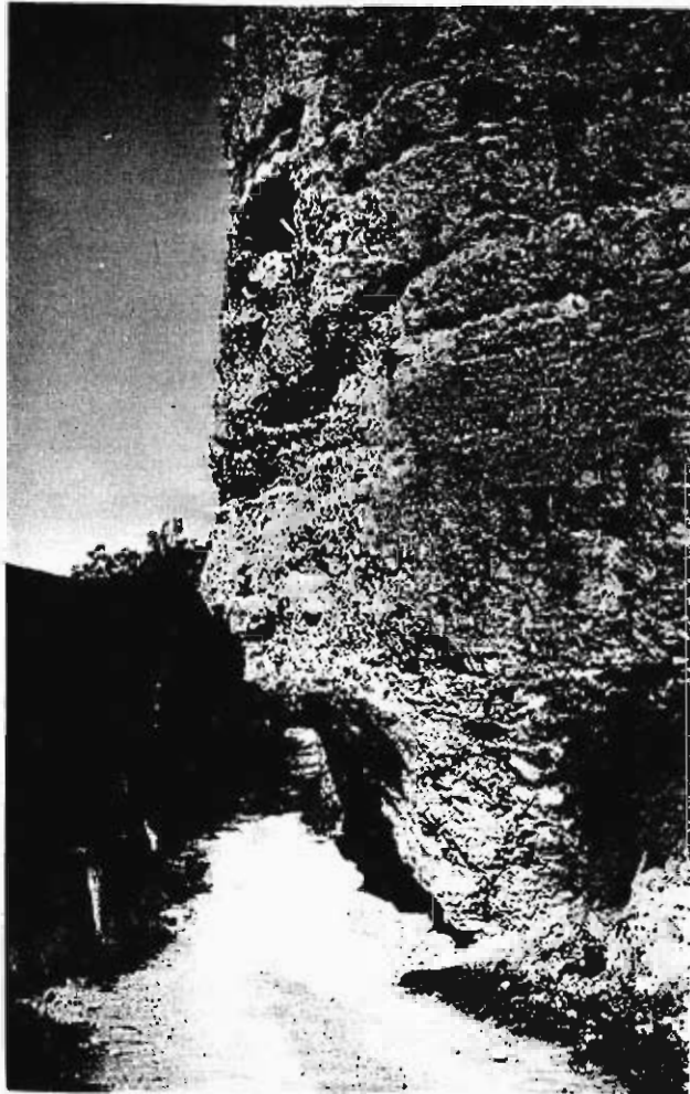
Foto 44.— Talud en voladizo de los conglomerados del Mioceno (321a) en Los Fayos.
