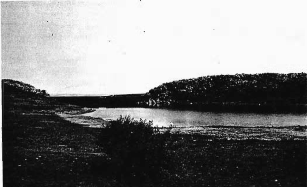
Foto 15.— Estribos de la presa de Huechaseca en calizas del Lías (221b) bien estratificadas en bancos.
