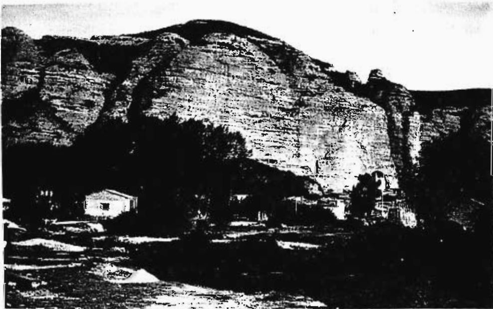
Foto 43.— Talud natural en los conglomerados del Mioceno (321a) en Los Fayos.
