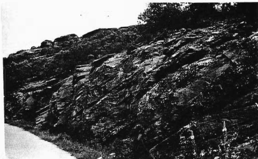
Foto 10.-- Detalle de un talud en areniscas del Bunt (211).
