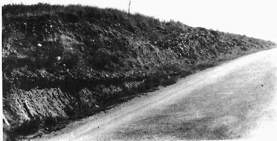
Foto núm 18. Formación detrítica del centro de cuenca. Obsérvese los niveles conglomeráticos sin cementar.
