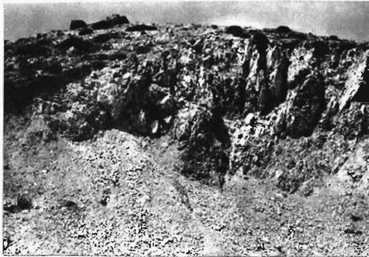
Fig. 48. Aspecto general del talud desarrollado sobre el grupo 211c. Observéense la alteración superficial que los afecta.
