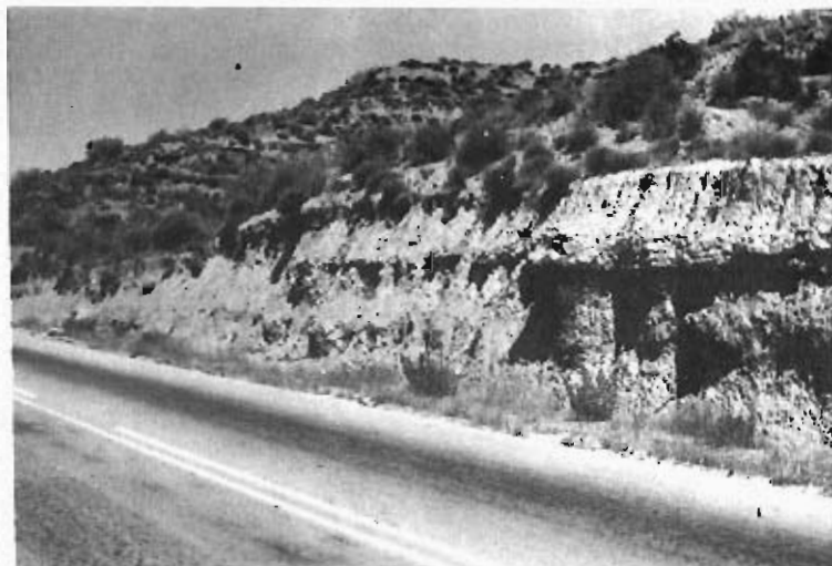
Fig. 64. Aspecto general de los taludes desarrollados en el grupo 350a. Obsérvense así mismo la disminución lateral de espesor del banco de conglomerados.
