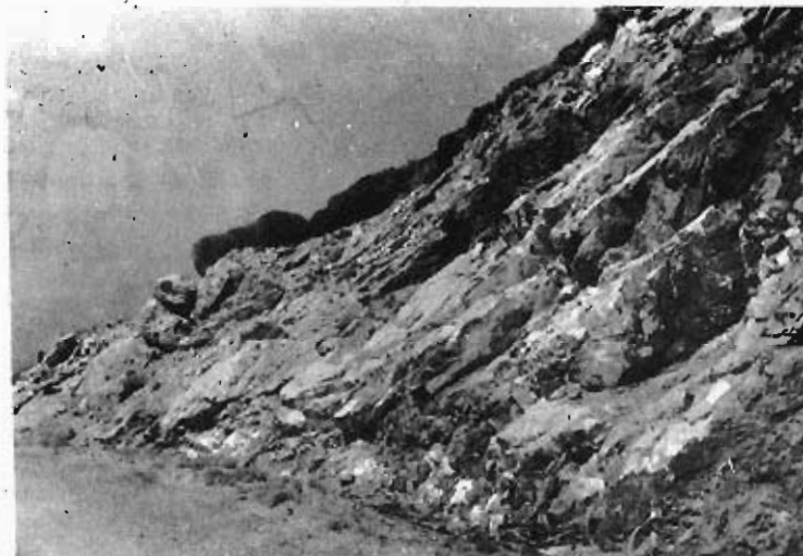
Fig. 26. Aspecto general de los taludes desarrollados sobre el grupo 100e.
