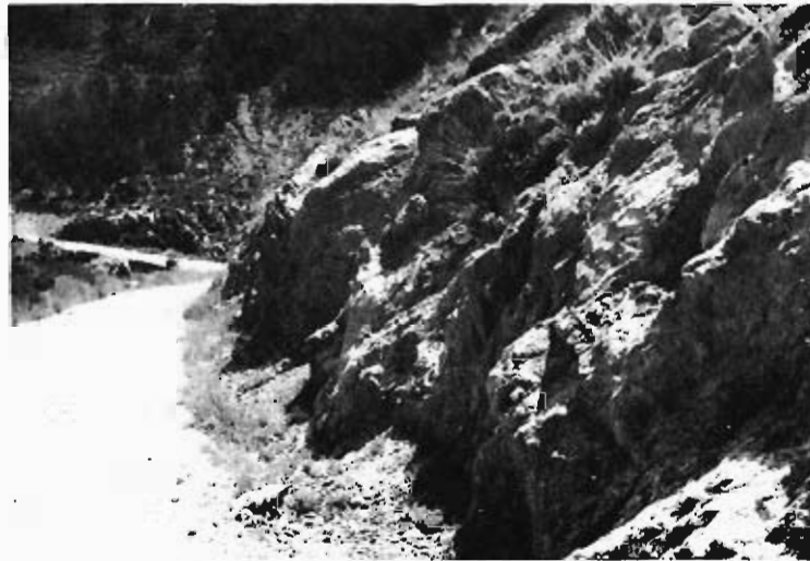
Fig. 35. Aspecto general de los taludes desarrollados en el grupo 213b.
