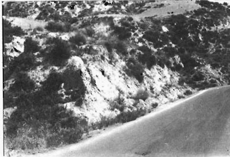
Fig. 60. Aspecto general del talud desarrollado en el grupo 321b.
