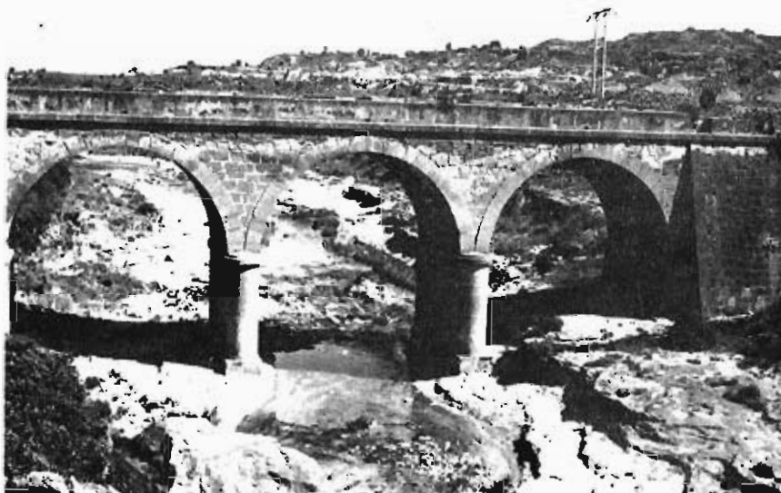
Foto 10.— Aspecto de la cimentación superficial sobre niveles duros de la Formación Sariñena (321 a)
