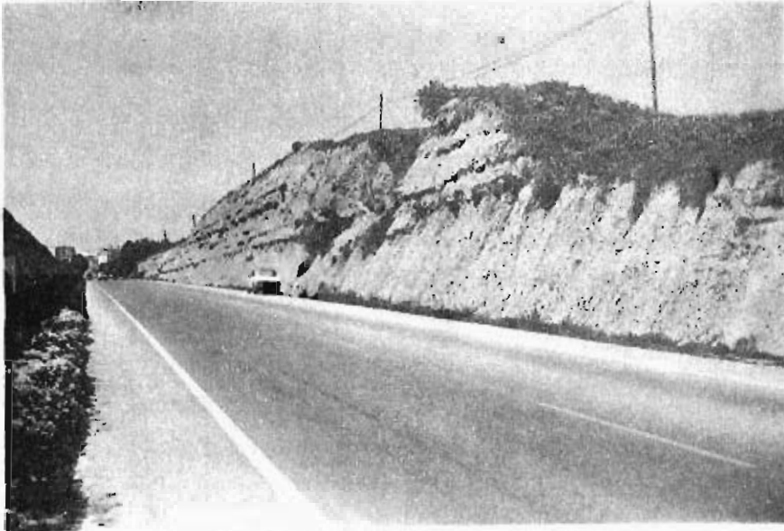
Foto 9.— Desmonte en la carretera N-240 de Huesca a Barbastro. Disposición horizontal de las capas.
