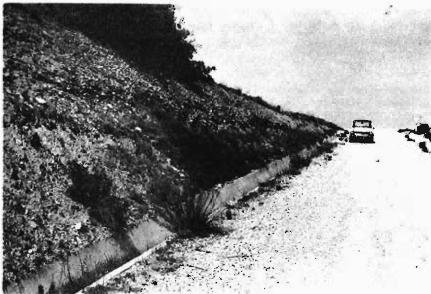
Foto 1.— Aspecto del talud del Glacis de Laluega (350 a)
