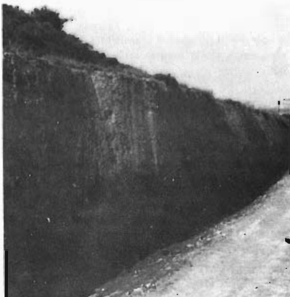
Foto 14.— Talud artificial en la formación A4 en estado de conservación bueno.
