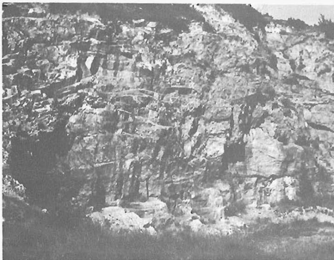
Foto 3.27.— Cantera abandonada de calizas del grupo 212a.
