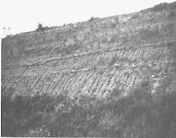
Foto 3.23.— Depósitos arcósicos con niveles de cantos del grupo 350, en un talud artificial perfectamente conservado.
