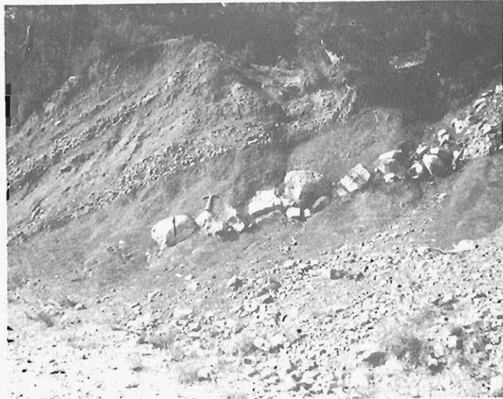
Foto 3.25.— Talud artificial en el grupo 311a donde se pueden apreciar los lentejones de conglomerados.
