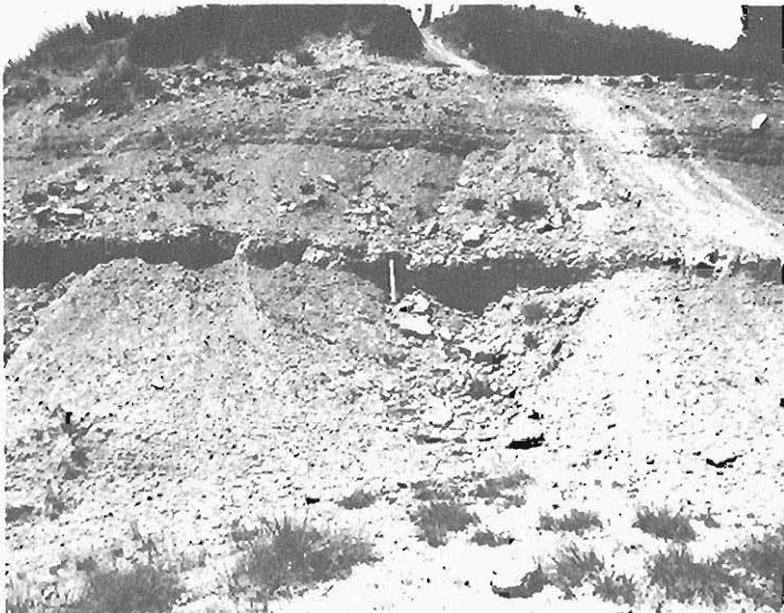
Foto 3.14.— Aspecto de un talud artificial en el grupo 312u.
