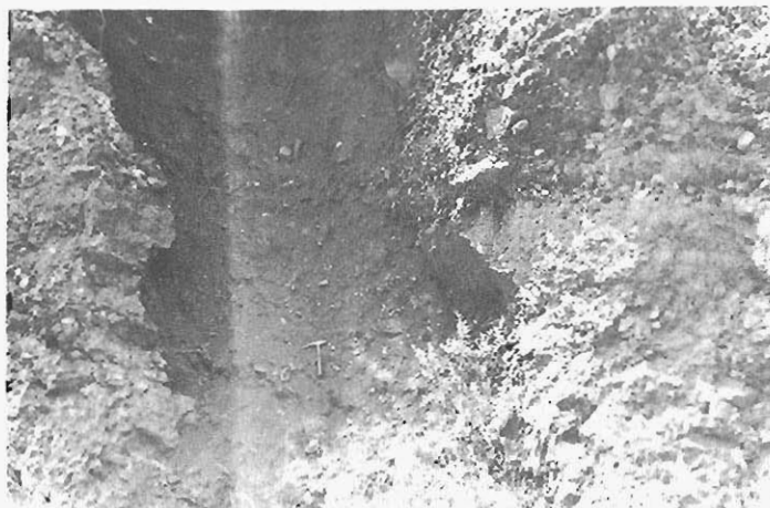
Foto 3.11.— Fractura rellena de materiales arcillosos en los conglomerados del grupo 312g.
