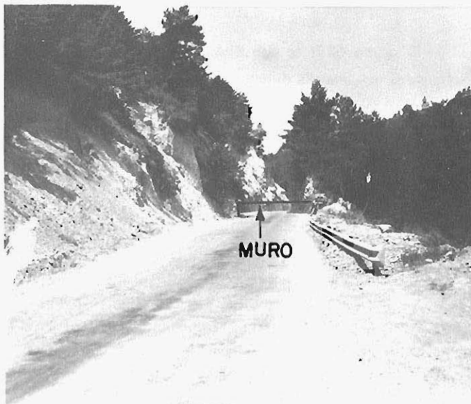
Foto 3.19.— Aspecto de los taludes artificiales inestables en los grupos 312p y 312t.
