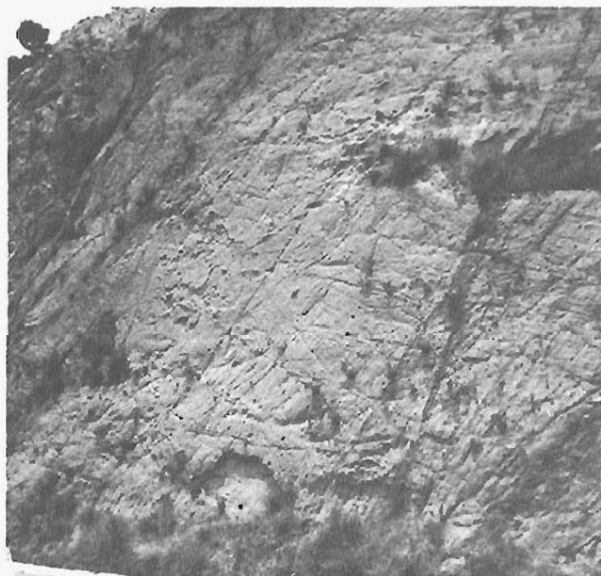
Foto 3.35.— Talud artificial en granito (O11).
