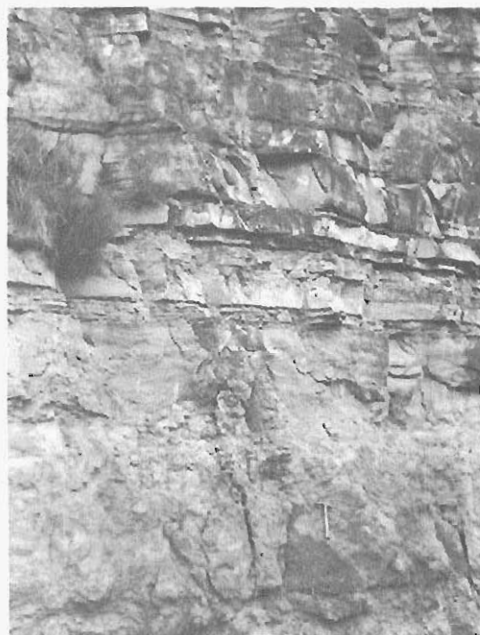
Foto 3.17.— Talud vertical en un afloramiento con estratificación fina del grupo 312d.
