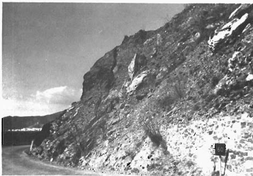
Foto 31.— Esquistos máficos (100b), inestables, buzando hacia el Sur. (carretera N—340, aproximadamente Km 29).
