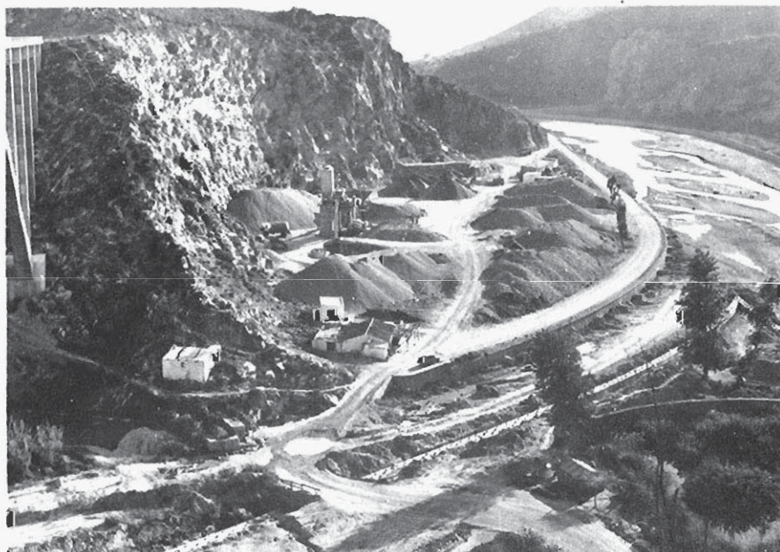
Foto 43.— Cantera abandonada (203'). Los montículos de áridos proceden de la gravera del río Escalante (200).
