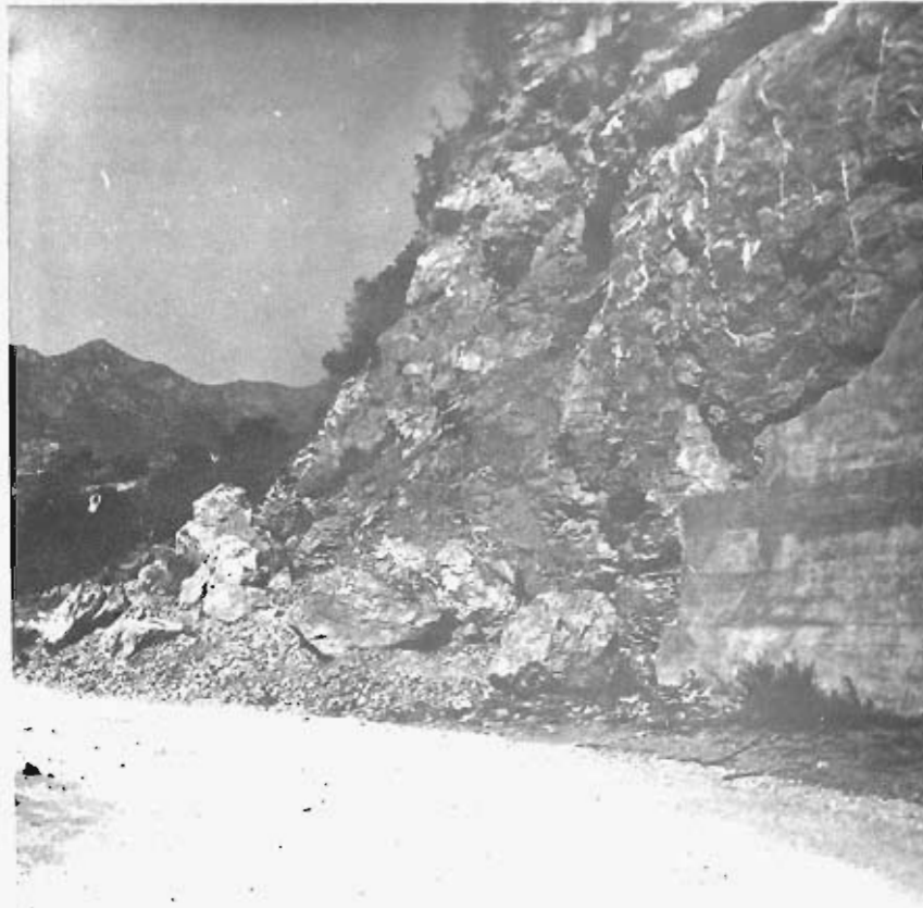
Foto 19.— Desprendimiento en calizas junto al río Guadalfeo (212a).
