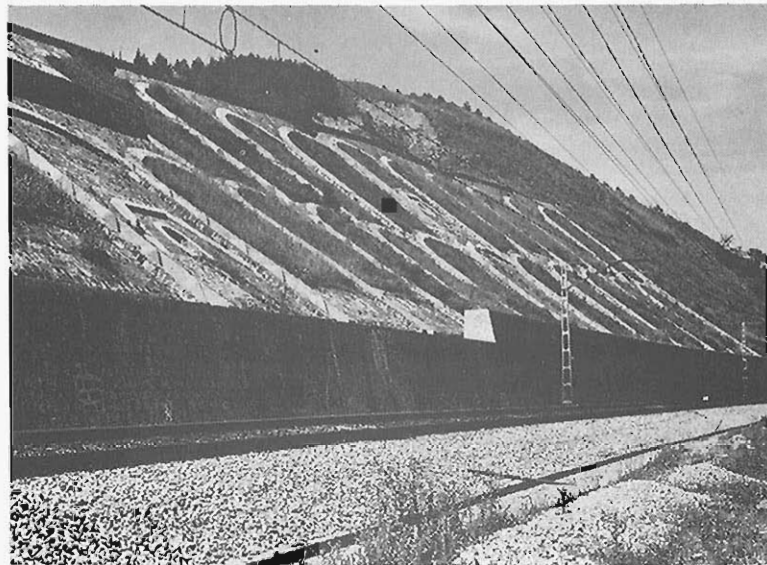
Fig. 36. Obras de contención y drenaje del grupo J (321 b) en el F.C. de Linares-Andújar, cerca de Villanueva de la Reina.
