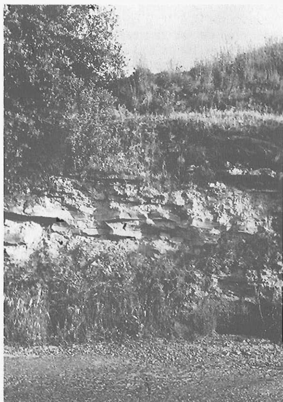
Fig. 25. El grupo K (311 c), en la carretera de Jabalquinto a la estación del F.C. del mismo pueblo.
