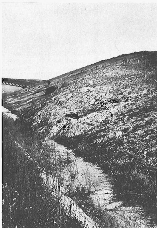
Fig. 24. Talud de la carretera N-IV, km 332, sobre el grupo J (321 a).
