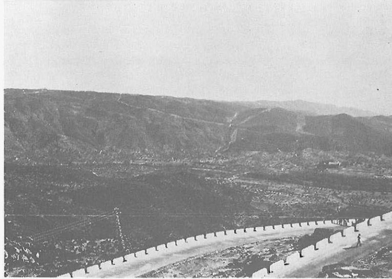
Fig. 13. Vista general del río Jándula, en las proximidades de El Lugar Nuevo.
