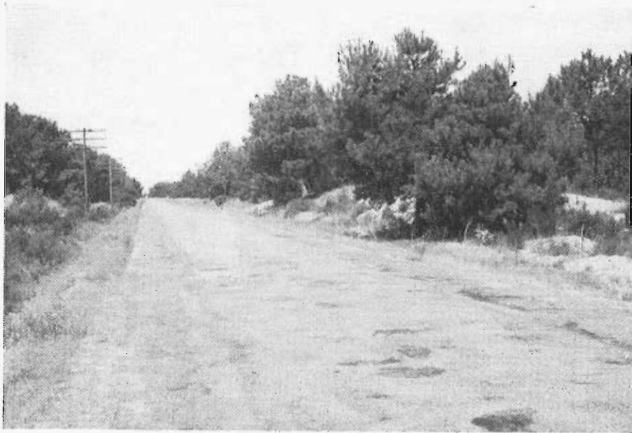
Fot. 46. Taludes parcialmente fijados por la vegetación en la carretera de Pollos a Tordesillas.
