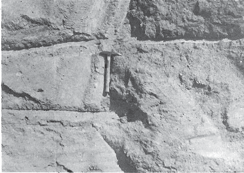
Foto 9.— “Facies Madrid” arcillo-arenosa cerca de Fuenlabrada, manteniéndolo un talud casi vertical.
