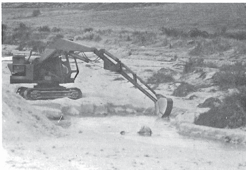
Foto 5.— Explotación de arena en el aluvial del río Guadarrama. C-581-2.
