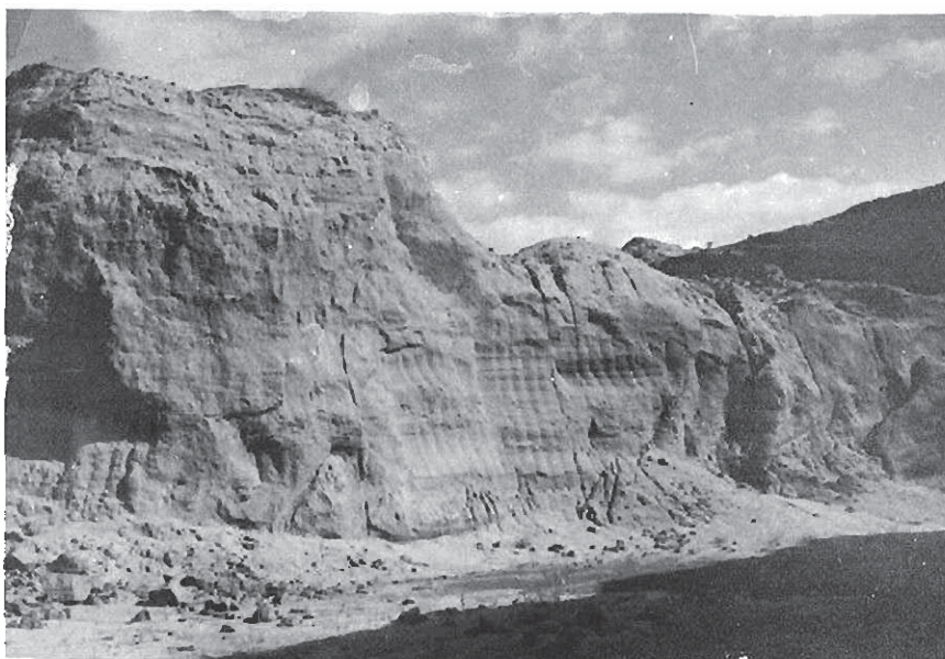
Foto 8.— Verticalidad de taludes, típica de la “Facies Madrid” cerca de Móstoles. C—581—1.
