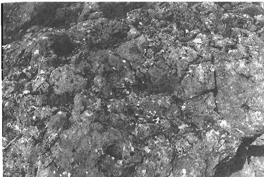
Fotografía 4. Aspecto superficial de las carniolas. Cantarable Qc-7. Fotografía de detalle.
