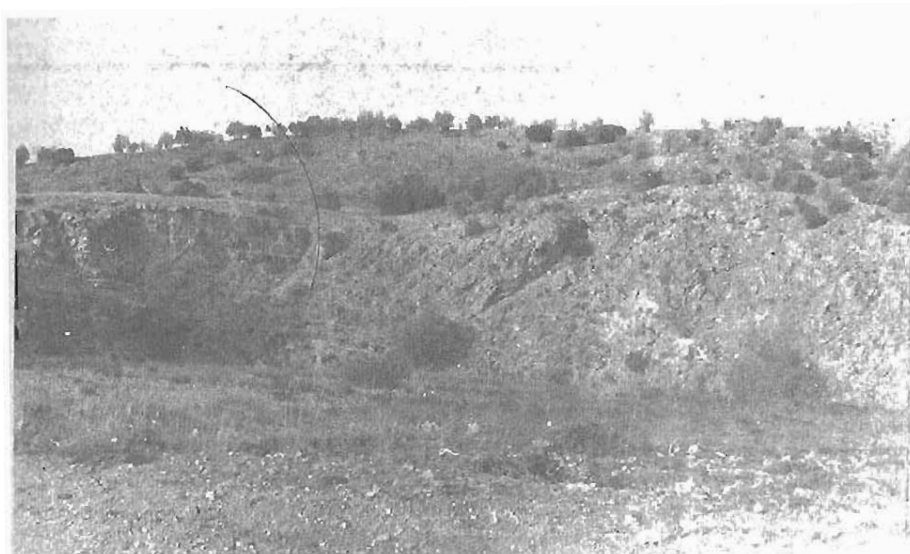
Fotografía 5. Falla observada en una uvata al NE de Layna entre calizas 3b y areniscas 3a.
