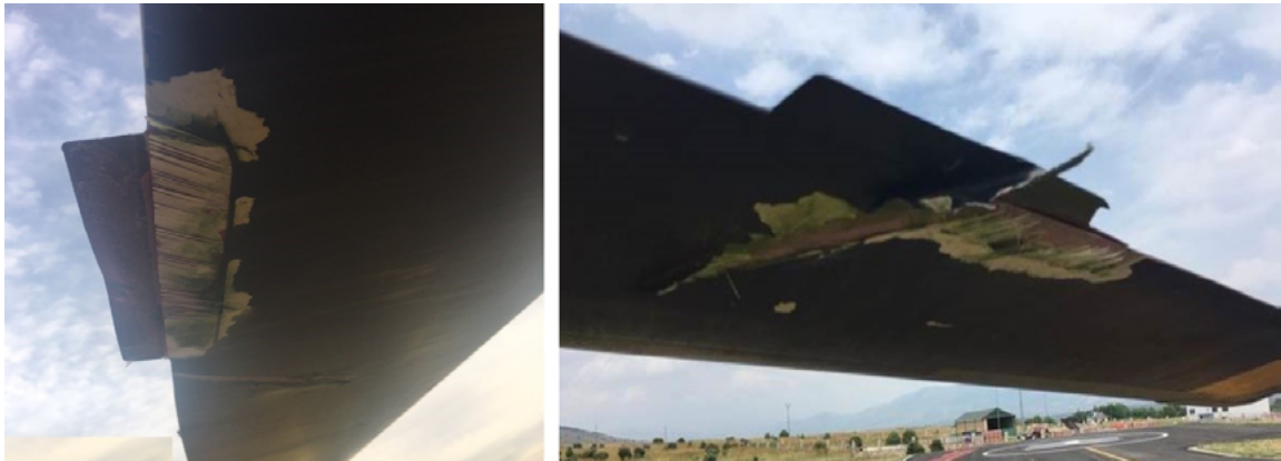
Figura 1. Daños en intradós
