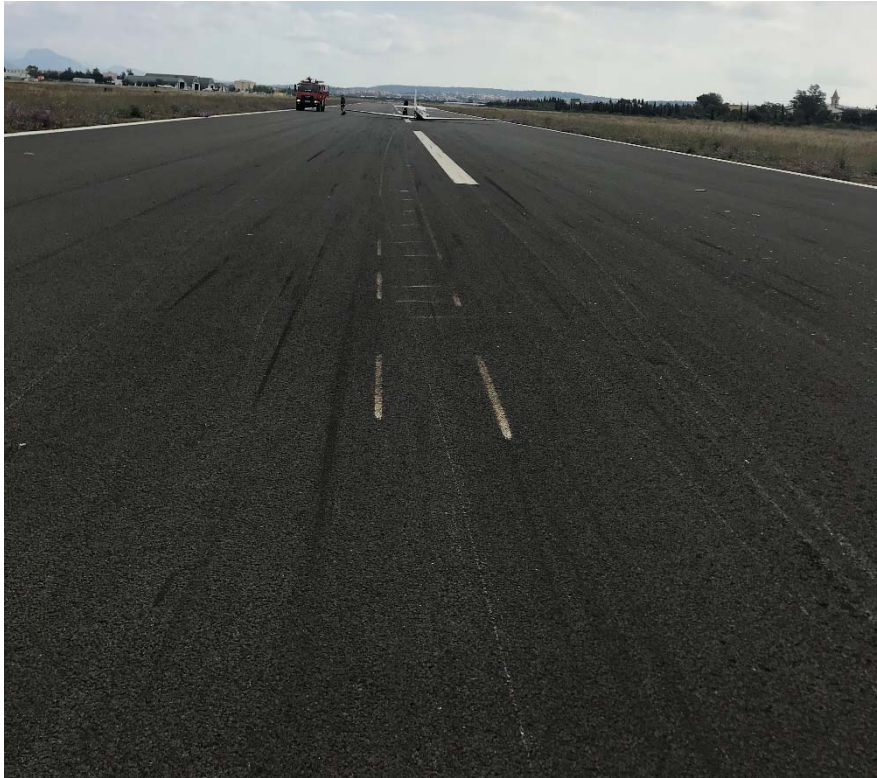
Ilustración 4: Marcas de la aeronave en la pista
