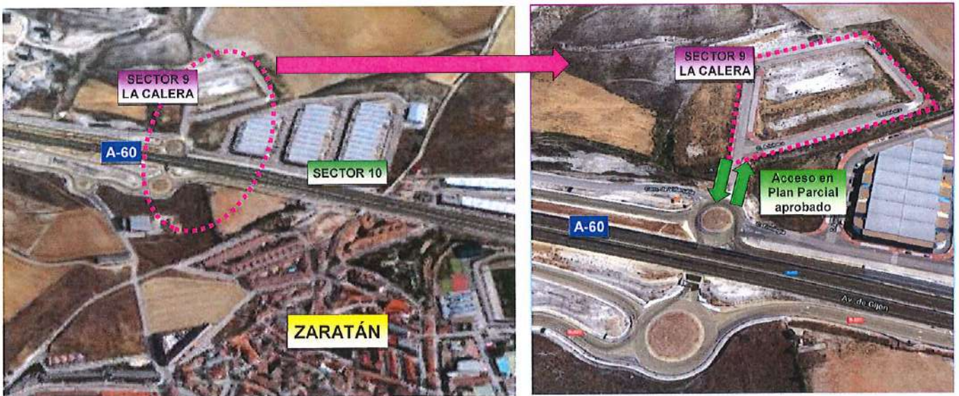
Situación del Sector 9 y del Acceso incluido en el Plan Parcial desde la glorieta del enlace
